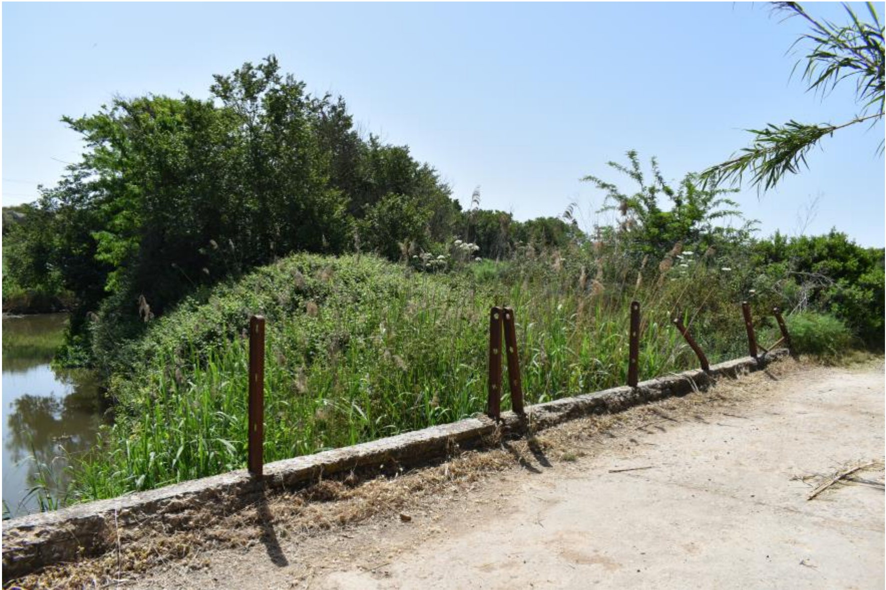
Ponte Riu Mannu - Ripresa fotografica ante-operam
