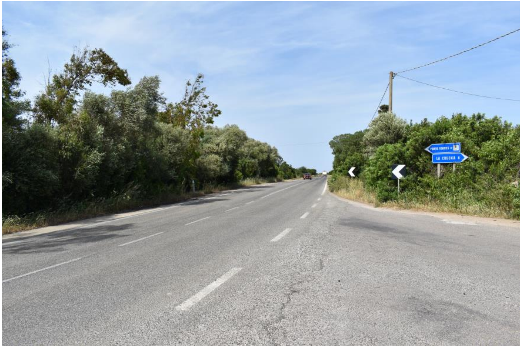
Strada SP42 - Ripresa fotografica ante-operam
