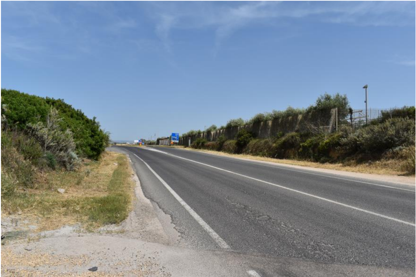
Strada SP34 - Ripresa fotografica ante-operam
