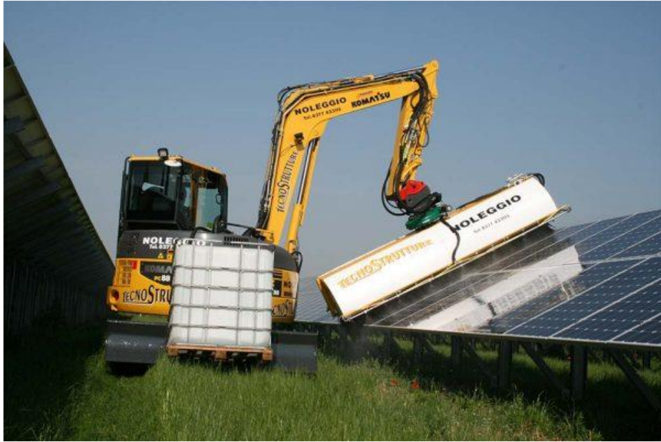
Sistema automatizzato lavaggio moduli fotovoltaici
