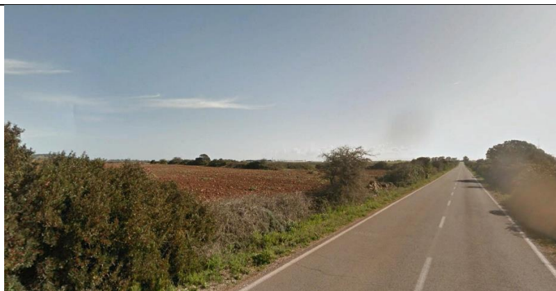
Altra Foto da Tratto 2 della SP18 verso l'area di impianto
