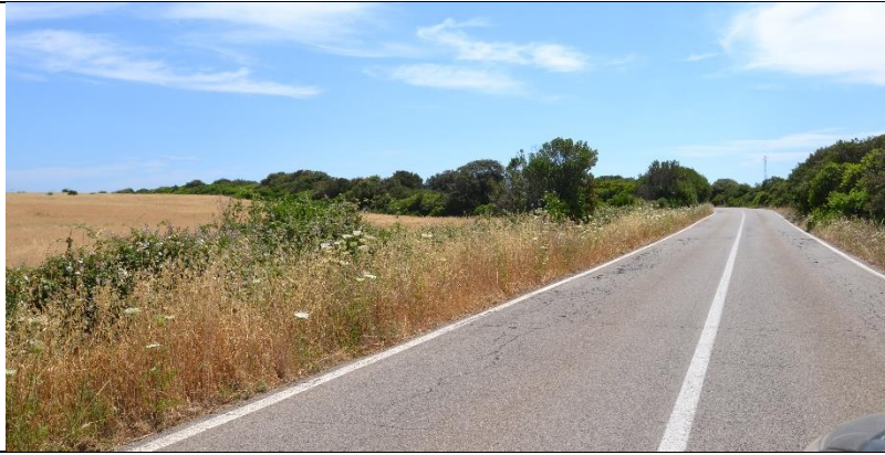
Foto da Tratto 1 della SP18 verso l'area di impianto
