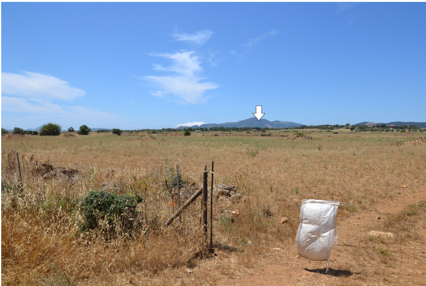
Punto 09 - Ripresa fotografica post-operam La siepe perimetrale mitiga la visibilità dei componenti di impianto
