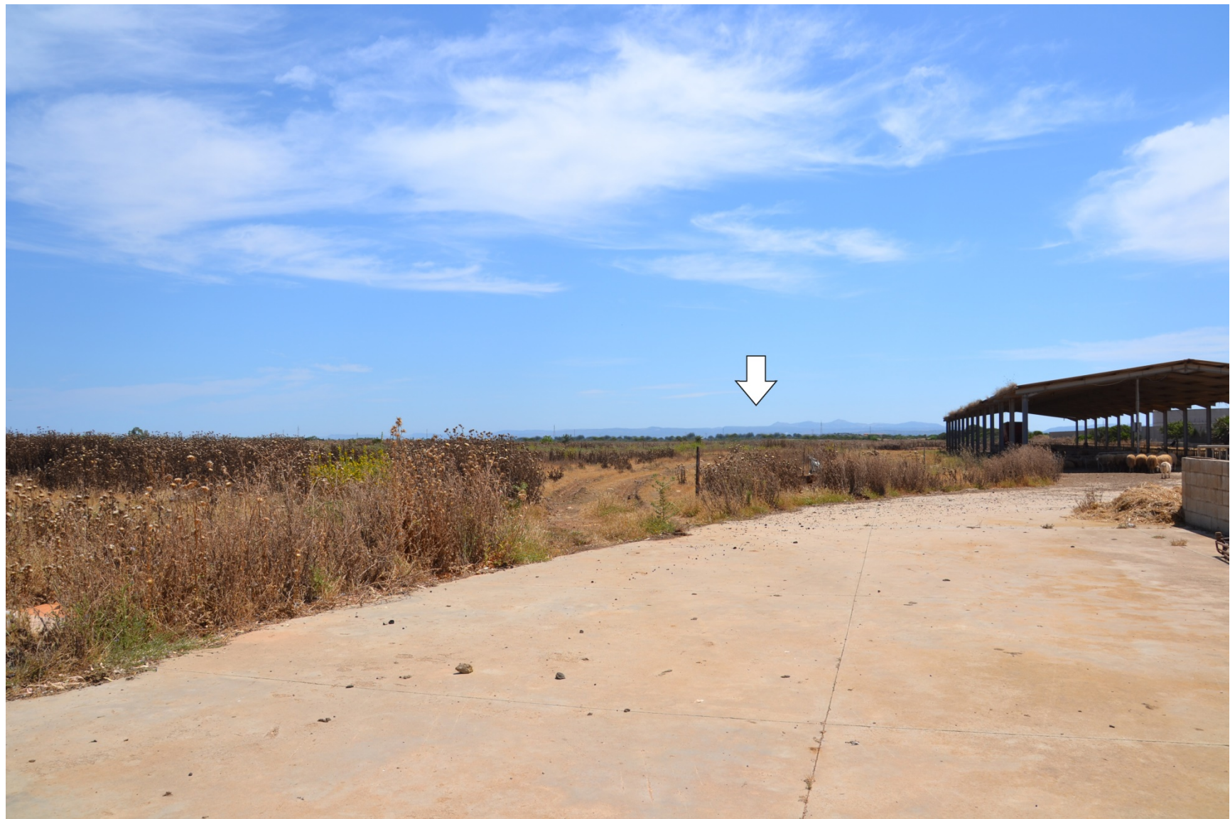
Punto 05 - Ripresa fotografica post-operam La siepe perimetrale mitiga la visibilità dei componenti di impianto
