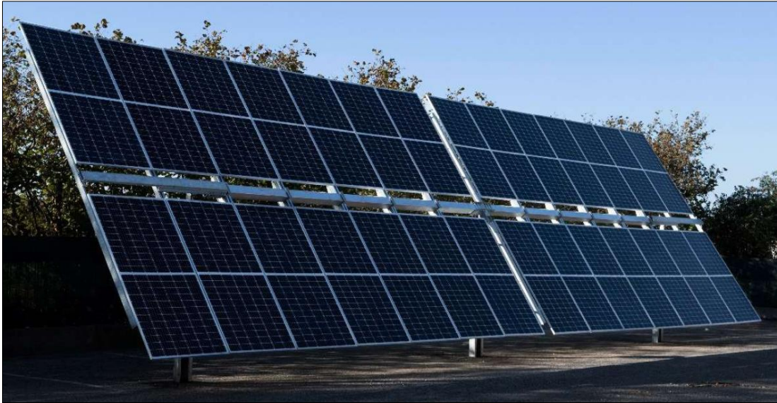
Figura 9-6. Allestimento dei pannelli su struttura tracker
