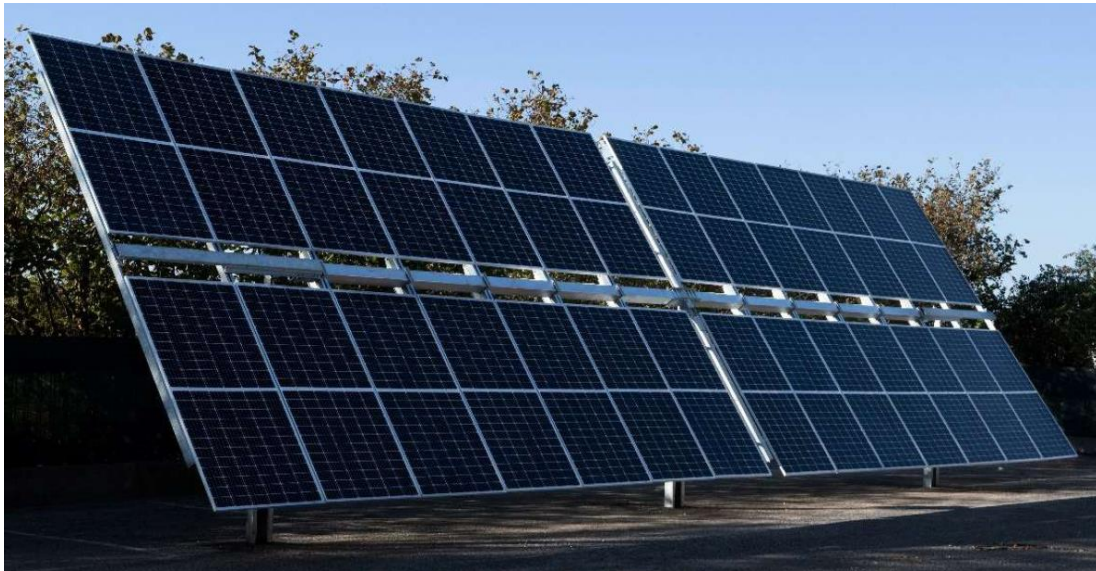
Figura 3-7 - Allestimento dei pannelli su struttura tracker
