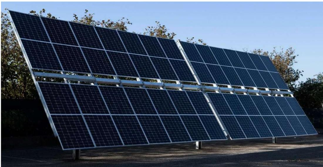
Figura 3-7 - Allestimento dei pannelli su struttura tracker
