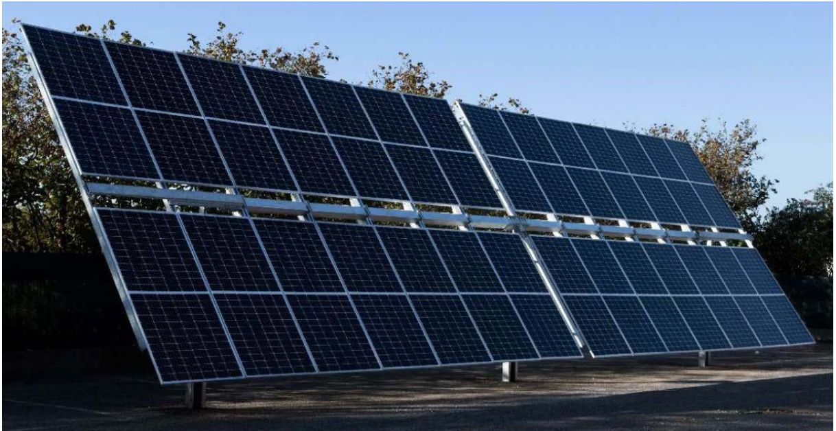
Figure 3 Immagine esplicativa dell'allestimento dei pannelli sulla struttura tracker
