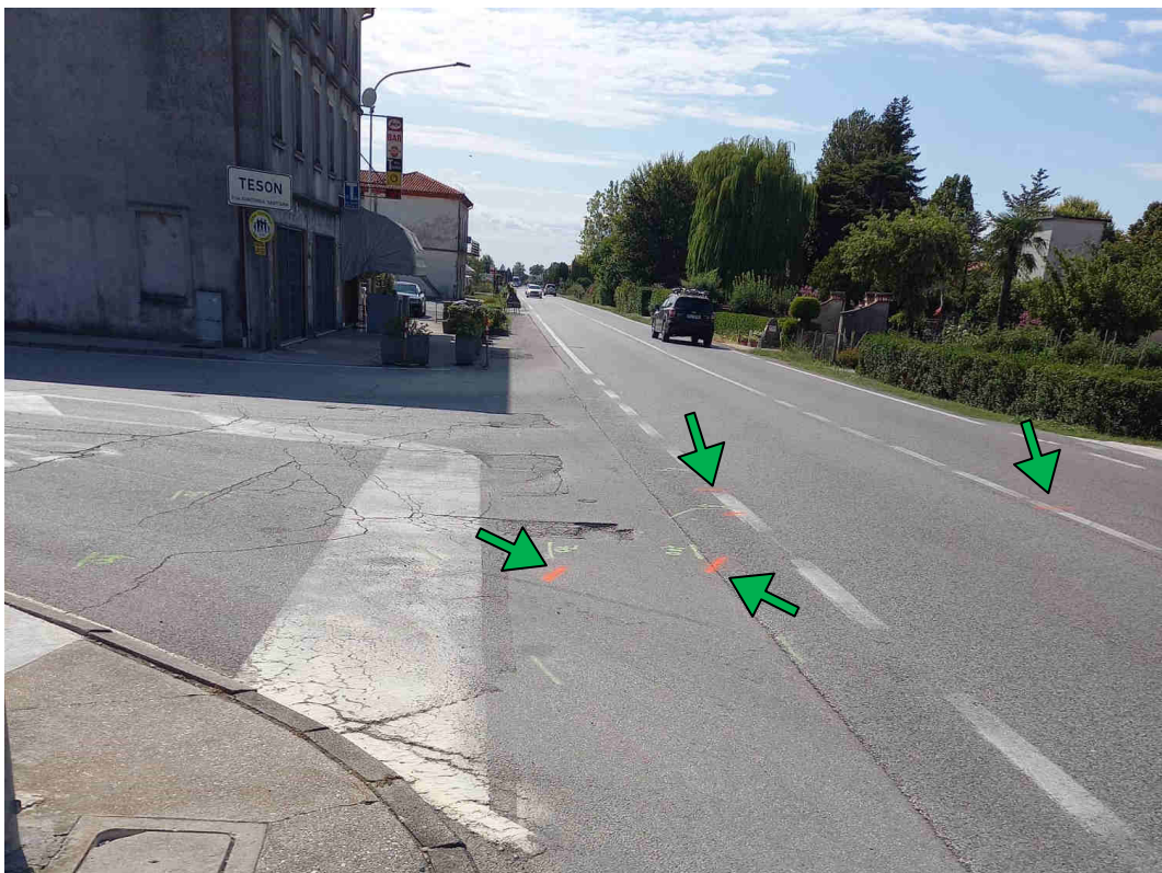
Fotografia 8 : Individuazione dei cavi esistenti (tracciamento 25/8/2021) presso incrocio Bandoquerelle
