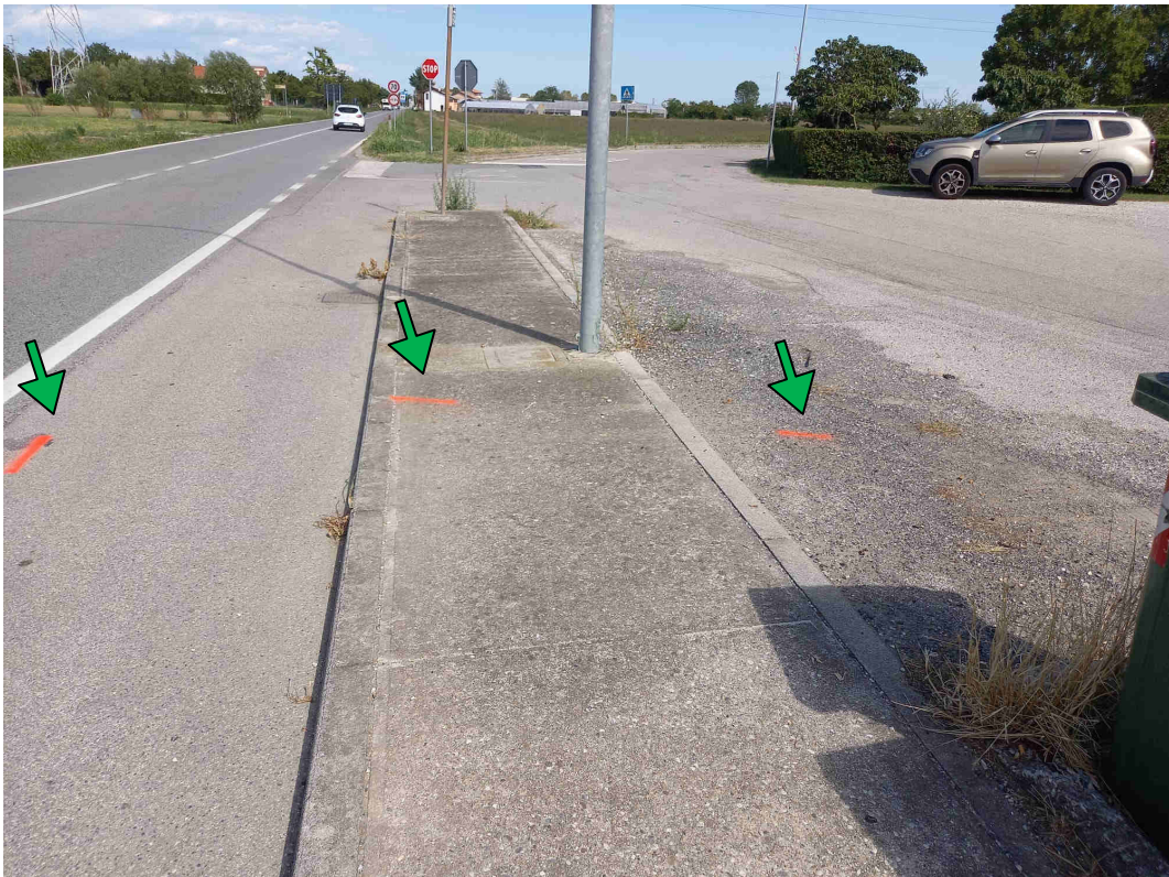
Fotografia 6 : Individuazione dei cavi esistenti (tracciamento 25/8/2021) presso incrocio Via Teson / Via Arrio
