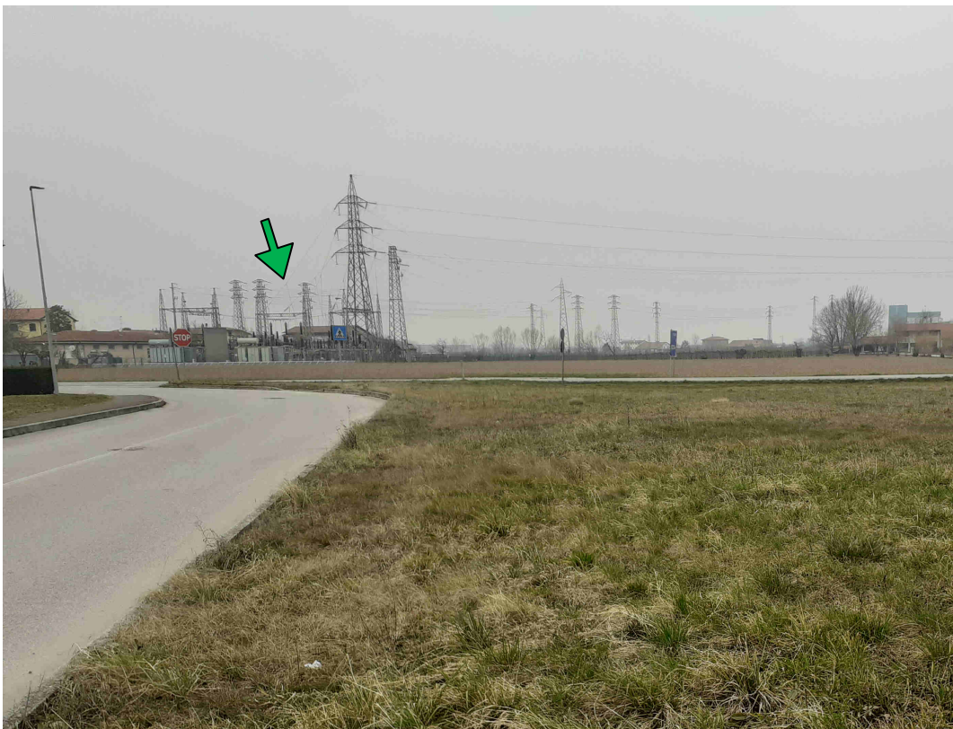
Fotografia 4 : Vista della Cabina Primaria "Levada" da Via Arrio
