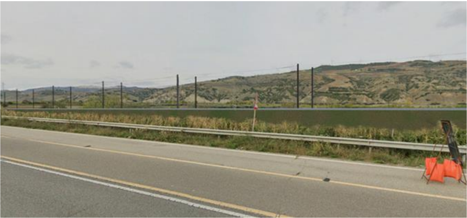
Fotosimulazione S1 – Post opera Vista in corrispondenza della pk 9+000 - Rilevato RI07
