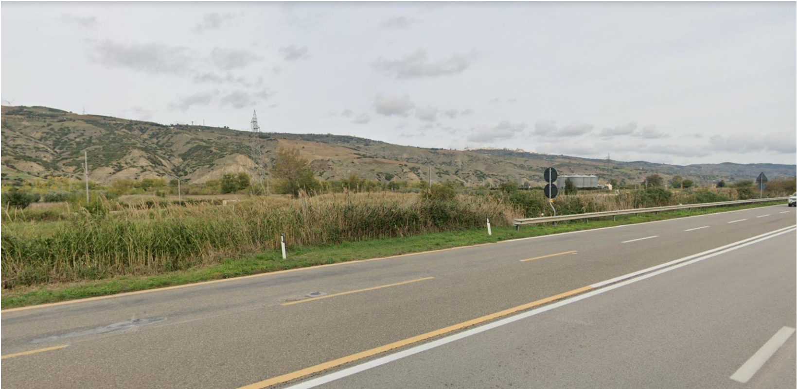
Foto 2 Ripresa dalla SS407 Basentana in corrispondenza della pk 9+100
