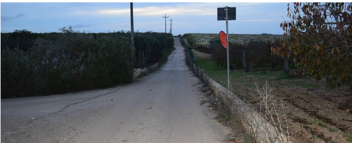
La strada percorsa dal cavidotto interrato tra A07 e A06.
