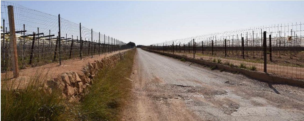
Strada vicinale Tarantina nei pressi dell'accesso all'aerogeneratore A06. Da questo punto parte il tracciato esterno del cavidotto interrato.
