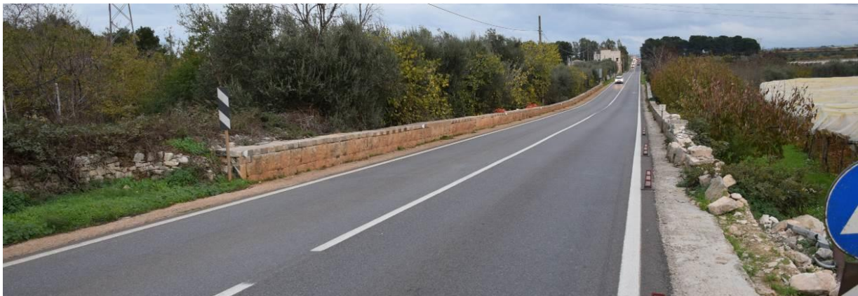
Tratto della SS172 interessata dalla posa del cavidotto; il tratto in questione sarà posato con TOC.
