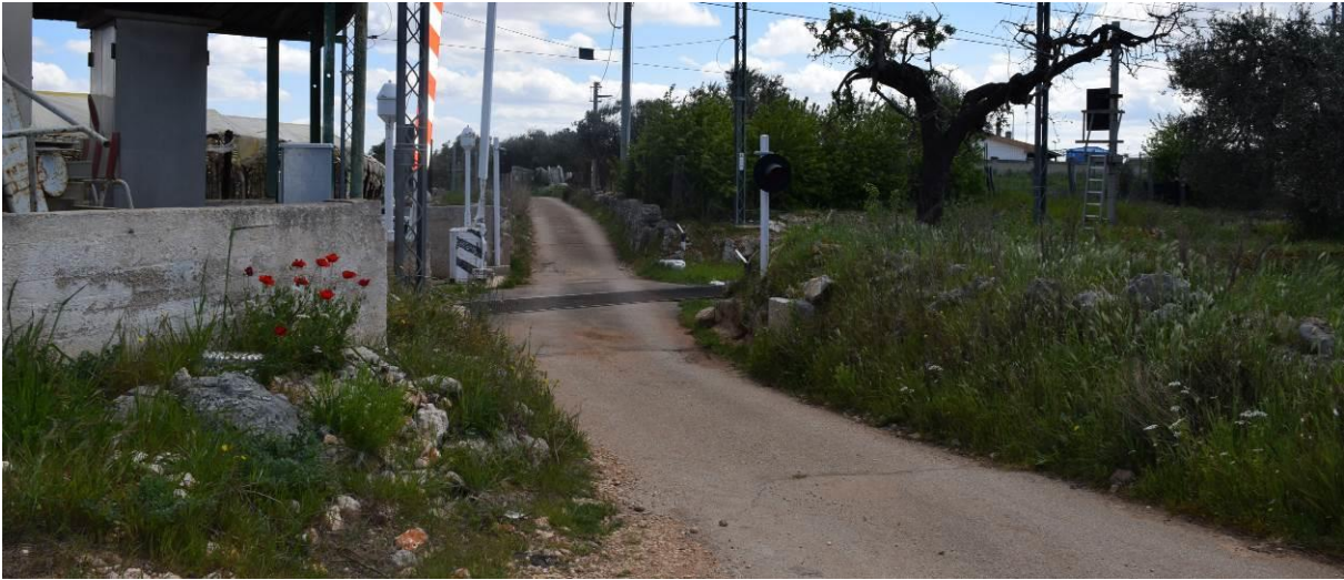
Attraversamento della ferrovia tramite TOC.
