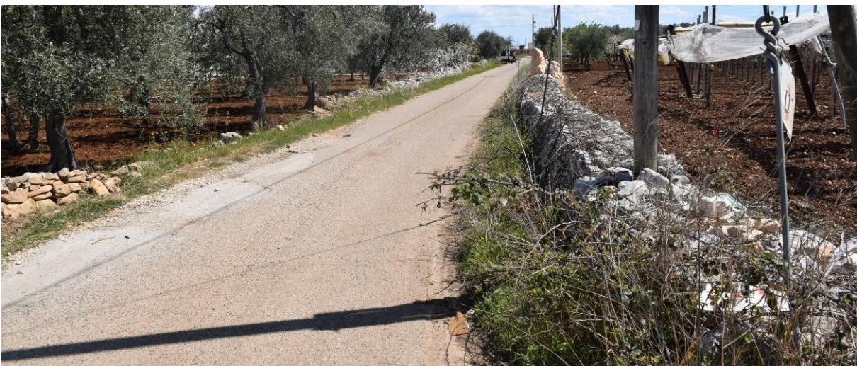
Tratto di cavidotto esterno su strada vicinale Cardo.
