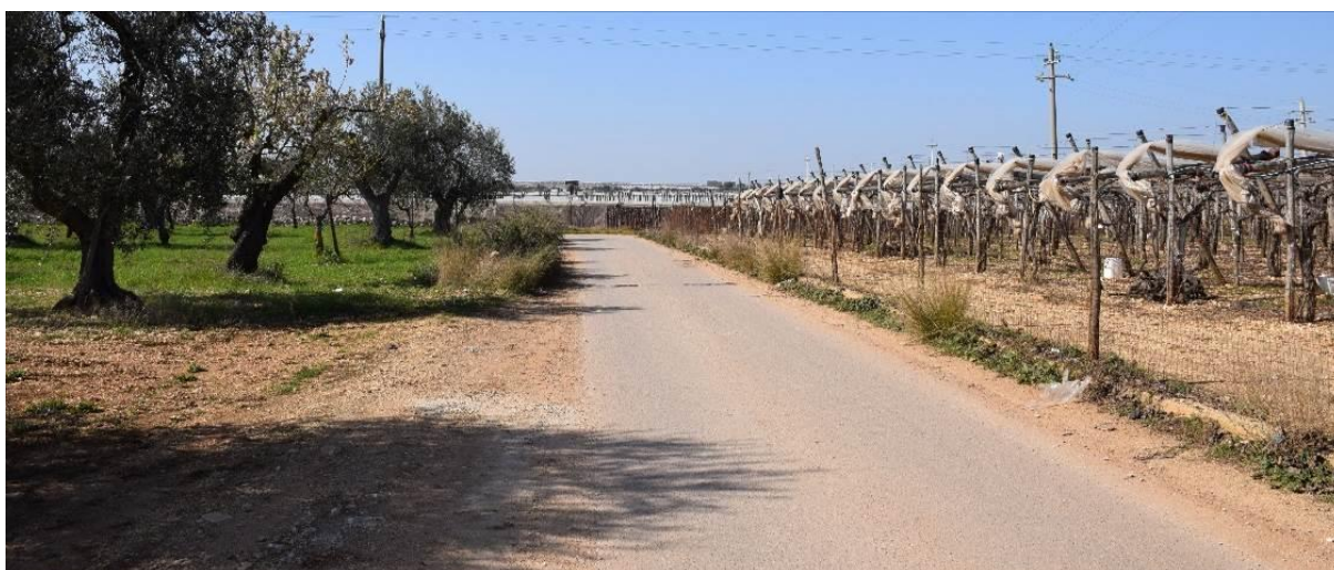
La strada asfaltata nei pressi dell'aerogeneratore A03.
