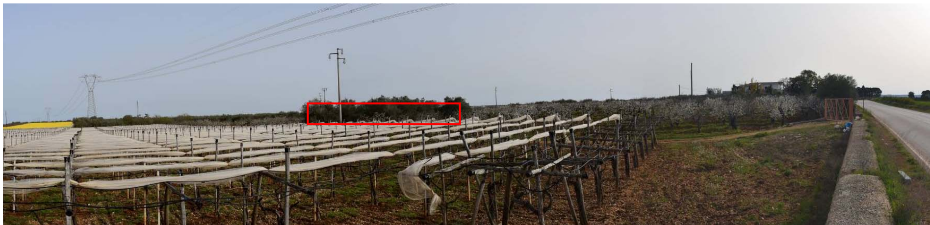
Figura 18: PAN1 _ vista della stazione di utenza e stazione di accumulo dalla SP 75. La foto è stata scattata dal muretto che costeggia la SP 75. Si osserva che da questo punto l'area di stazione non è visibile. La copertura vegetazionale impedisce la vista della stazione di accumulo e dell'intera stazione di utenza.
