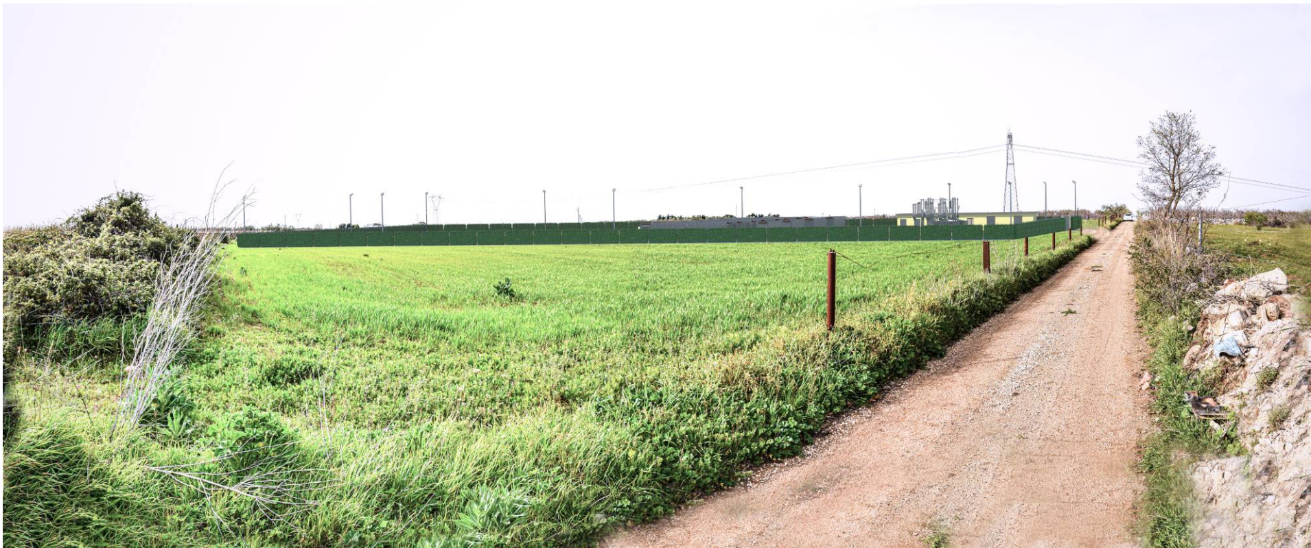
Figura 25: PAN 3_vista dell'area destinata alla realizzazione della stazione di utenza e stazione di accumulo dalla strada esistente di accesso dallo spigolo sud_ STATO DI PROGETTO con l'utilizzo della specie Lingustrum Vulgare come mitigazione visiva.
