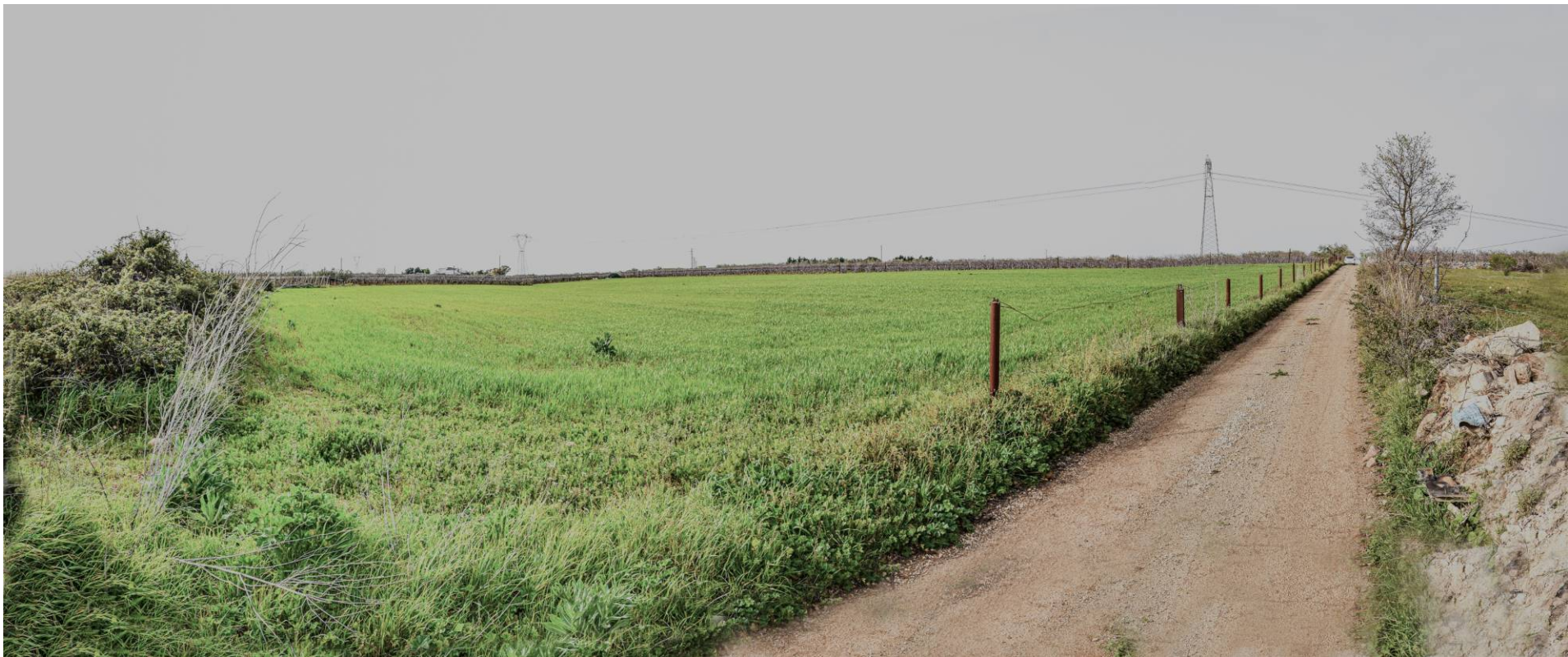
Figura 23: PAN 3_vista dell'area destinata alla realizzazione della stazione di utenza e stazione di accumulo dalla strada esistente di accesso dallo spigolo sud_STATO DI FATTO
