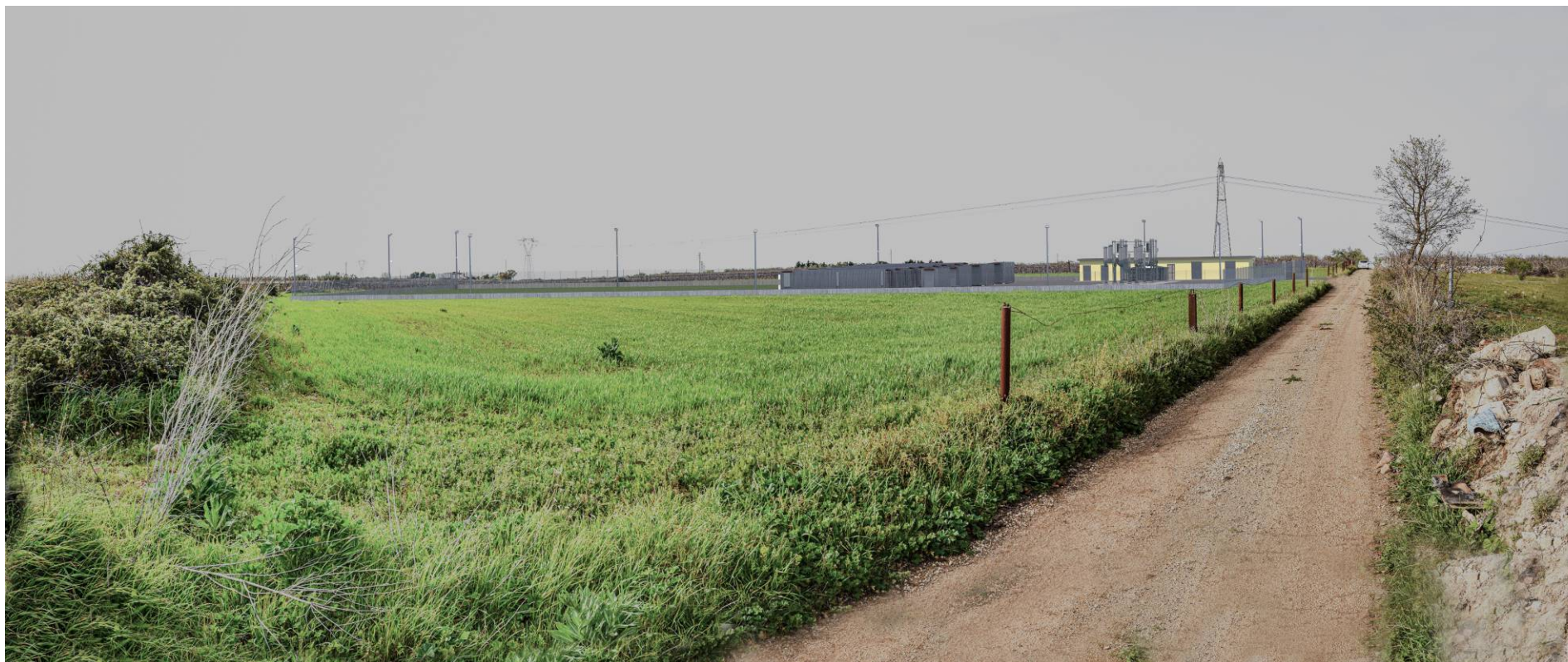
Figura 24: PAN 3_vista dell'area destinata alla realizzazione della stazione di utenza e stazione di accumulo dalla strada esistente di accesso dallo spigolo sud_ STATO DI PROGETTO senza mitigazioni.
