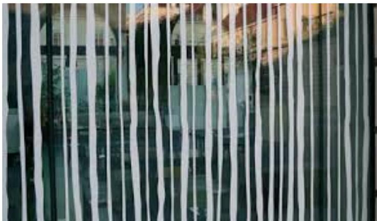
Figura 11 – Esempio di vetro serigrafato con motivi geometrici verticali
