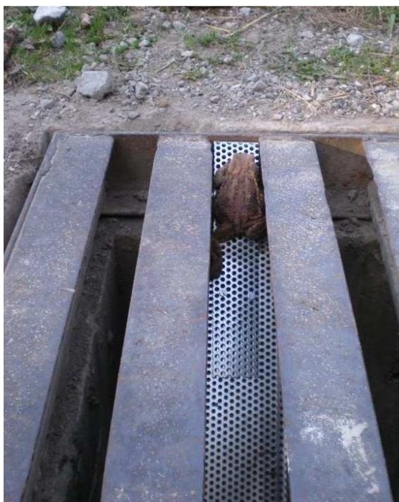
Figura 12 – Esempio di rampa per la risalita di anfibii
