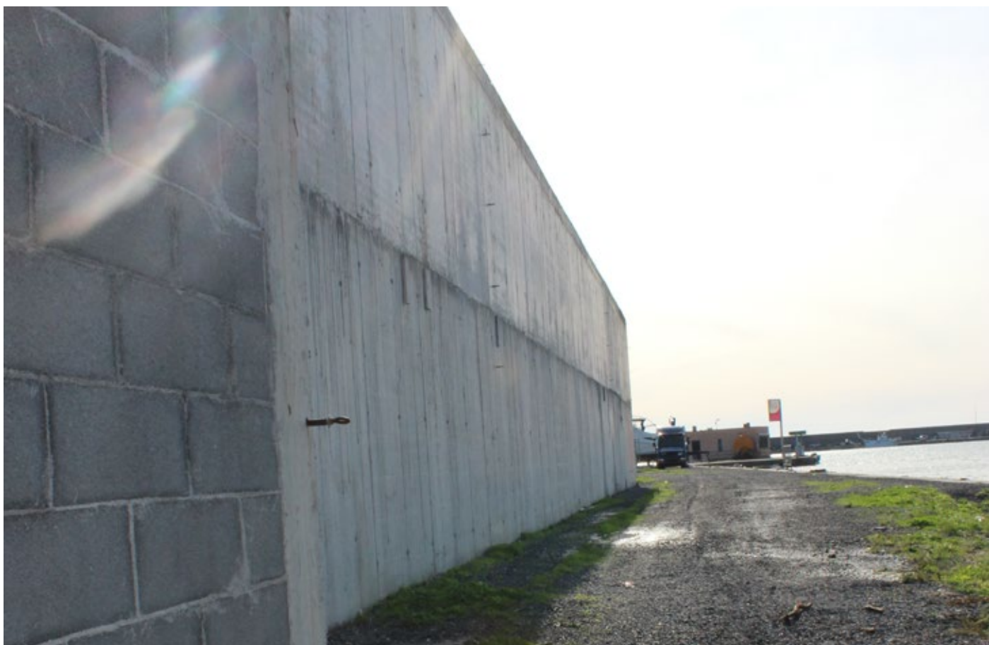
16. Prospetto ovest Vista da nord-ovest del prospetto ovest e del distributore di carburante.
