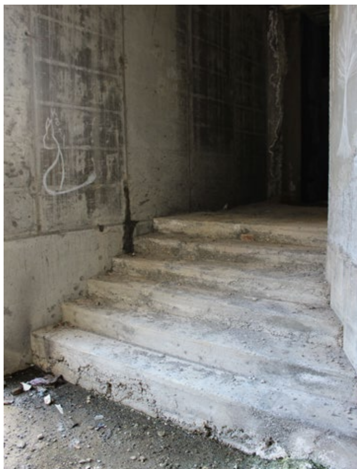
32. Scala dislivello piano terra autorimessa e piano terra zona est
