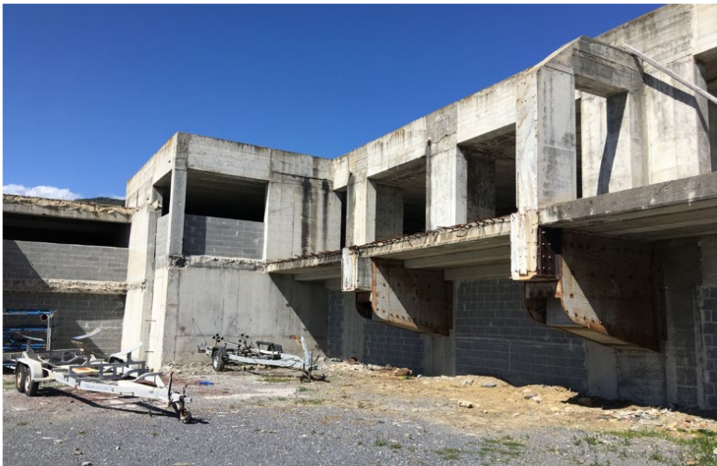
14. Dettaglio prospetto ovest
