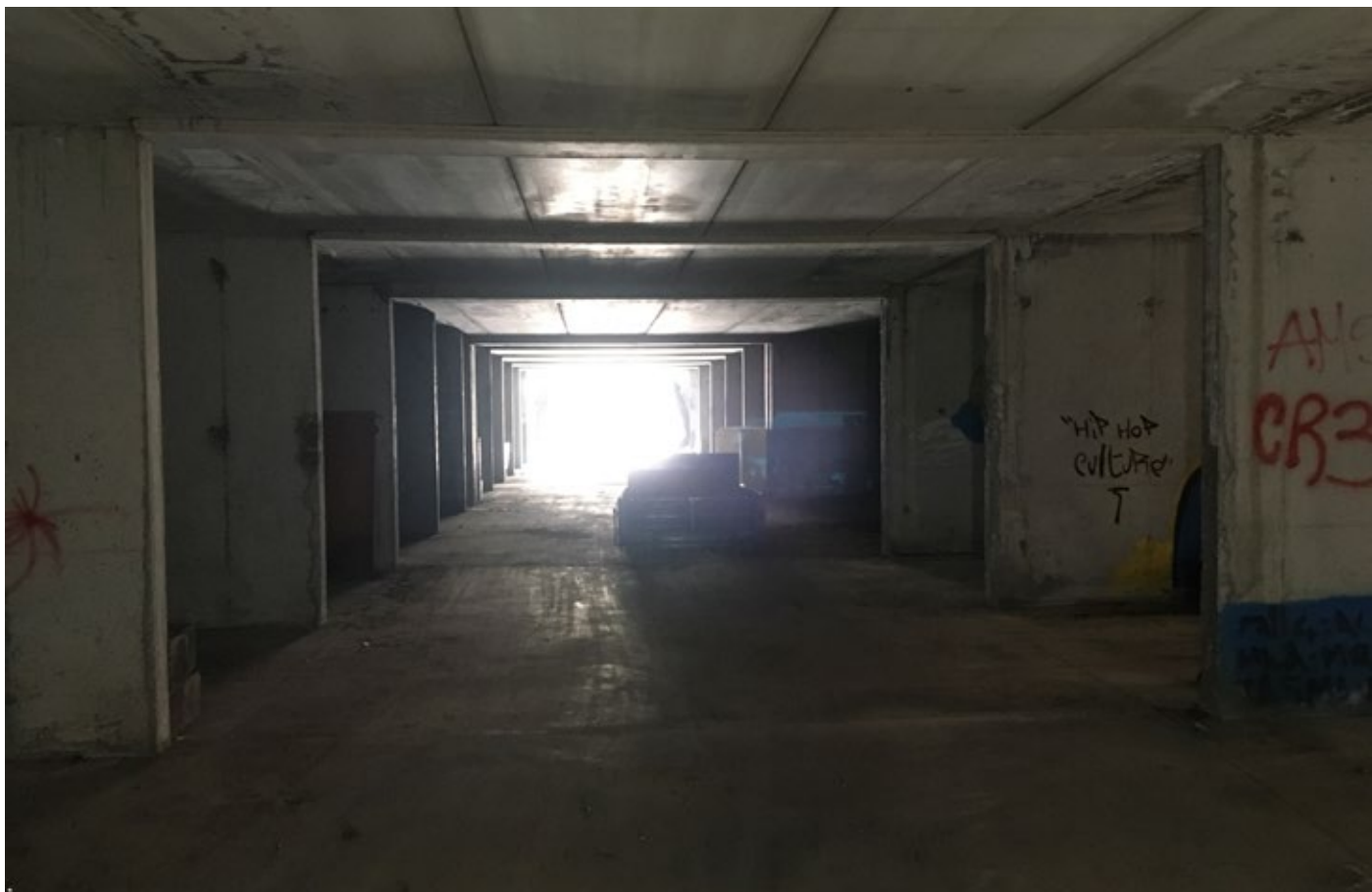
21. Controcampo ingresso prospetto nord
