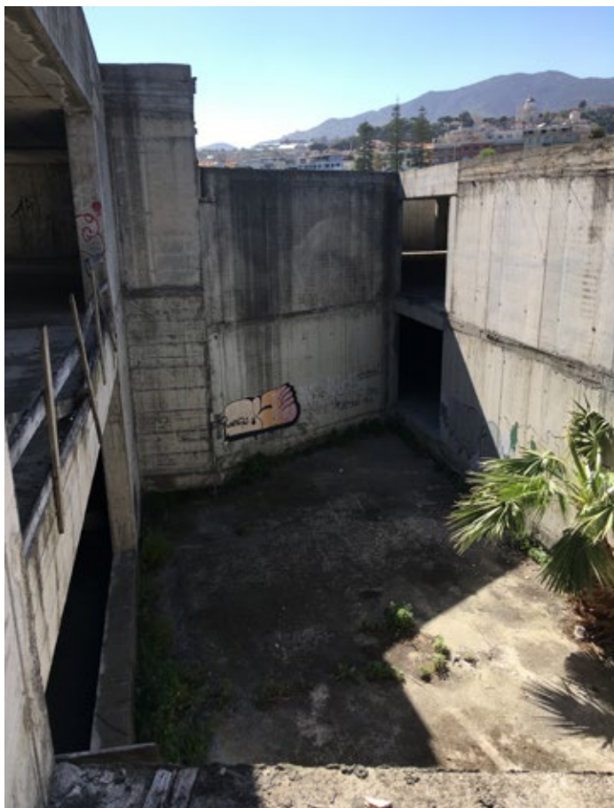
37. Vista corte centrale da piano primo
