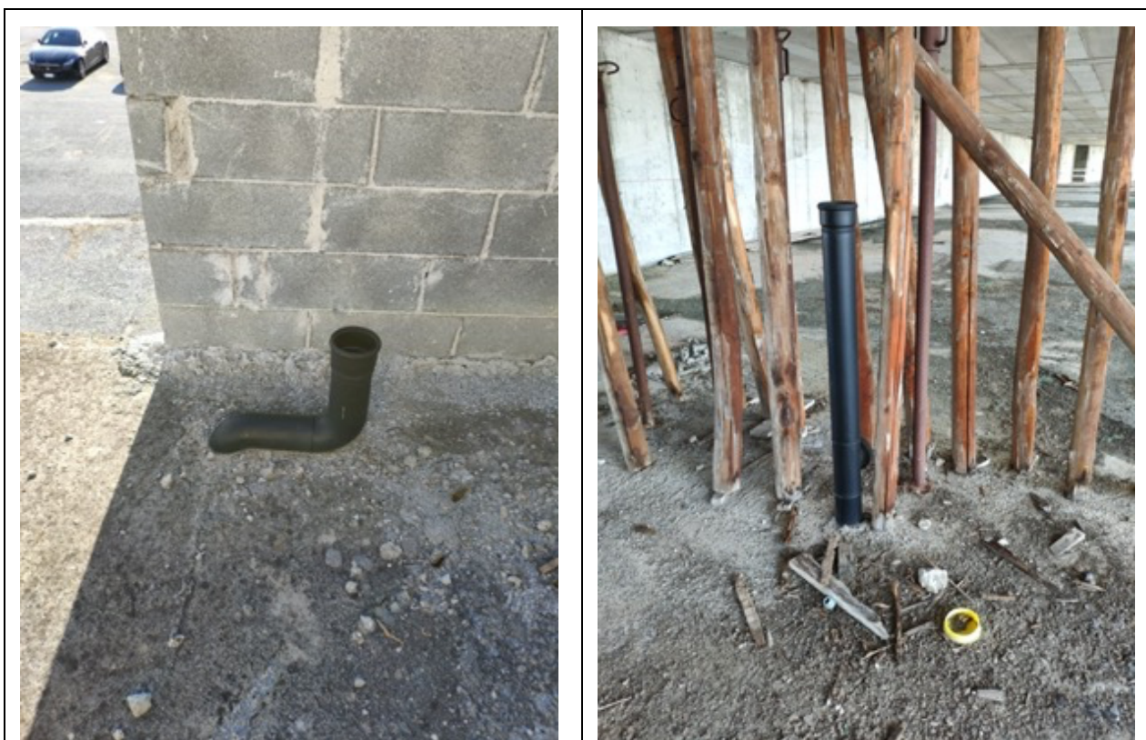
Figura 19. Discendenti in pvc – acque nere – Blocco B1 e B2.
