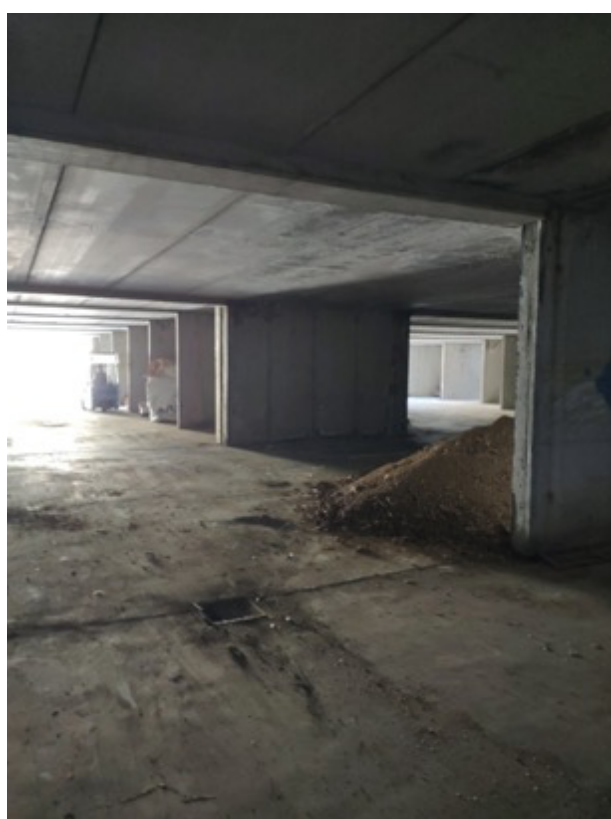
Figura 21. Locali al piano terra – Blocco A.
