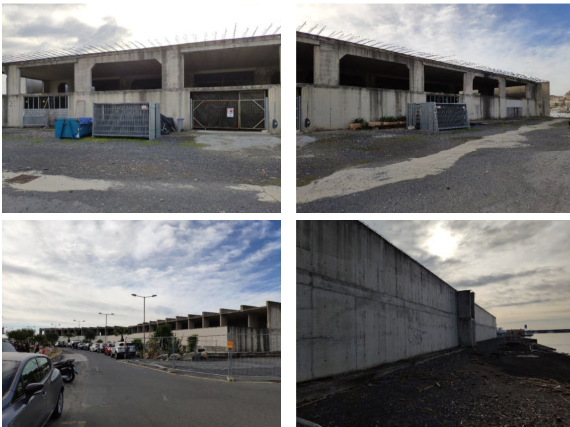
Figura 1. Viste dell'attuale struttura in c.a.
