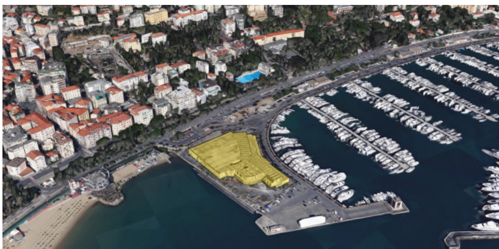
Figura 2. Vista aerea con localizzazione della struttura da demolire
