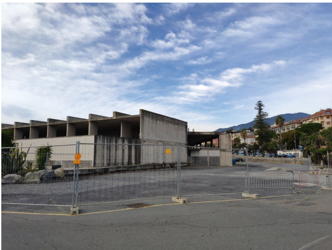
Figura 5. Zona in cui sarà predisposto l'accesso al cantiere
