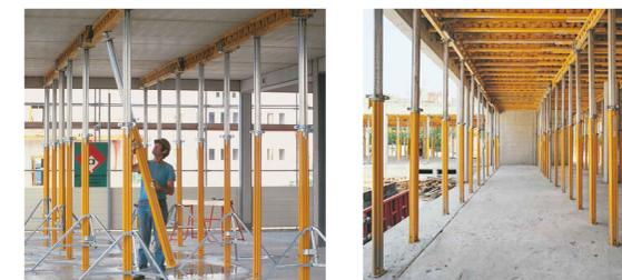
Esempi di installazione di puntelli in alluminio per soletto, di peso ridotto e portata elevata
