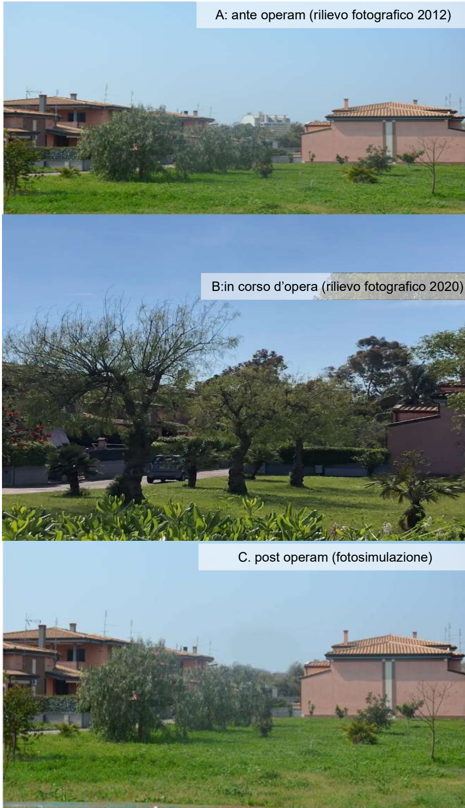
Figura 10.8 - punto di vista 9: A: ante operam (rilievo fotografico 2012), B: in corso d'opera (rilievo fotografico 2020) C. post operam (fotosimulazione)
