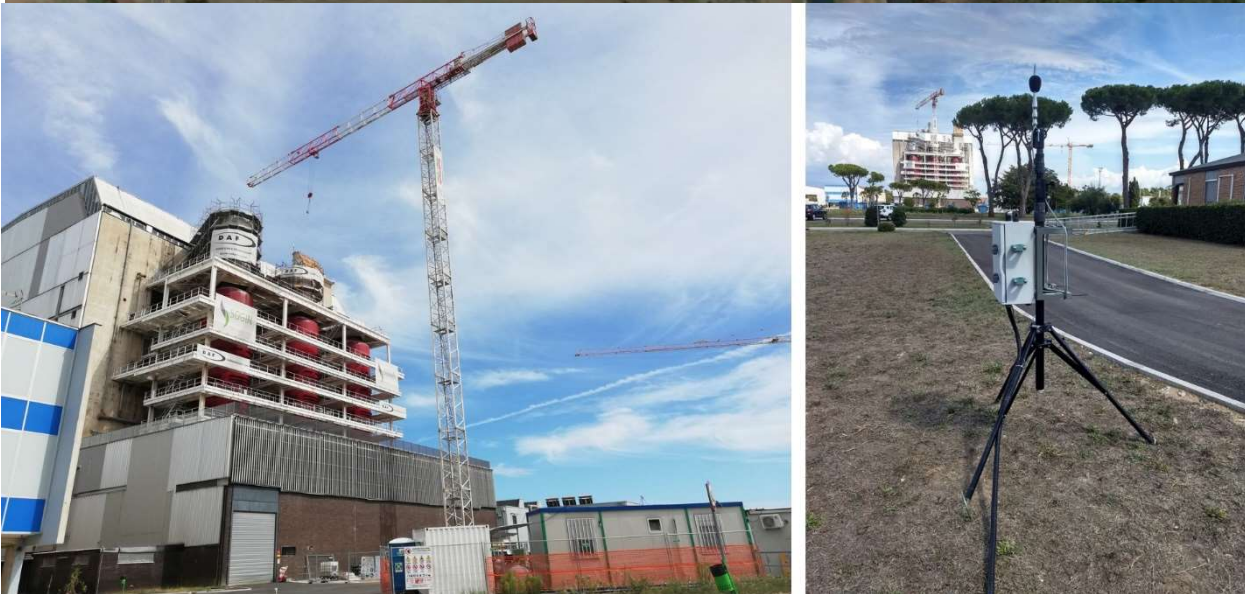
Figura 6.5 - Ubicazione dell'area di cantiere del punto di screening R11 – documentazione fotografica di alcune sessioni di monitoraggio sul lato Ovest
