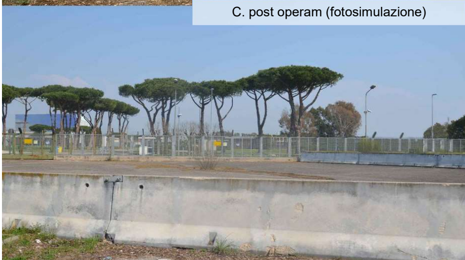
Figura 10.4 – punto di vista 2: A: ante operam (rilievo fotografico 2012), B: in corso d'opera (rilievo fotografico 2020) C. post operam (fotosimulazione)
