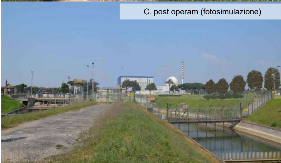
Figura 10.9 punto di vista 18: A: ante operam (rilievo fotografico 2012), B: in corso d'opera (rilievo fotografico 2020) C. post operam (fotosimulazione)
