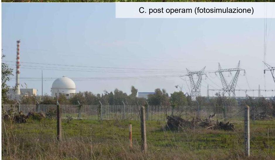
Figura 10.7 – punto di vista 6: A: ante operam (rilievo fotografico 2012), B: in corso d'opera (rilievo fotografico 2020) C. post operam (fotosimulazione)
