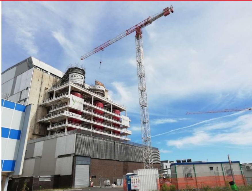
Figura 4.8 - Edificio Reattore - Cantiere di taglio degli schermi Boiler
