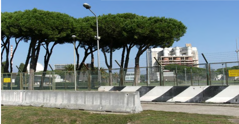
B: in corso d'opera (rilievo fotografico 2021)
