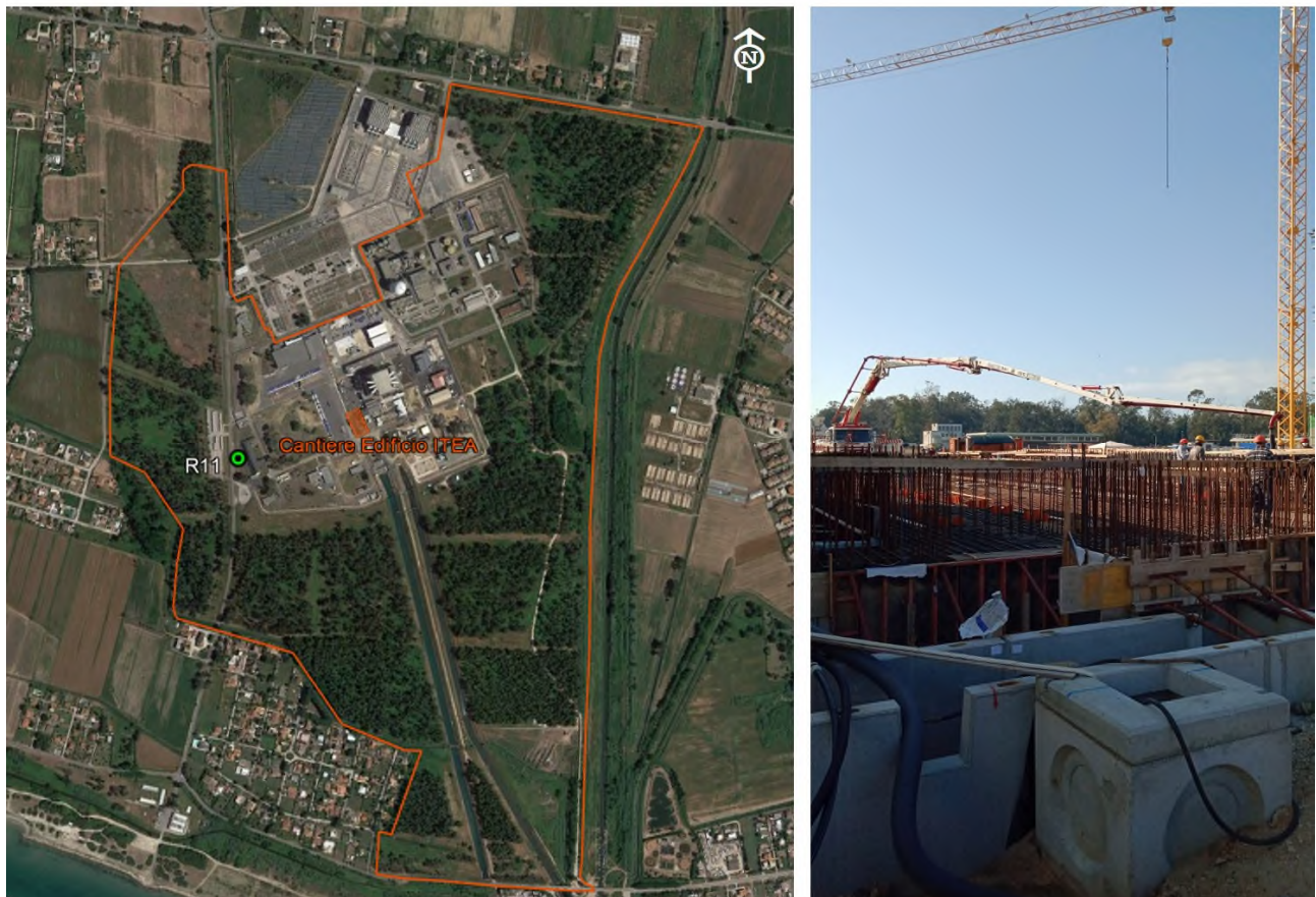
Figura 6.3 - Ubicazione dell'area di cantiere e del punto di screening R11
