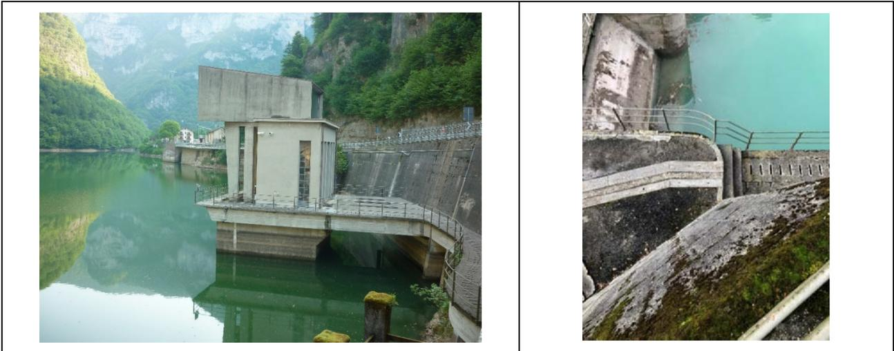
Figura 7-17: fotografia del camminamento che collega sfioratore e opera di presa passando sotto la casa di guardia.
