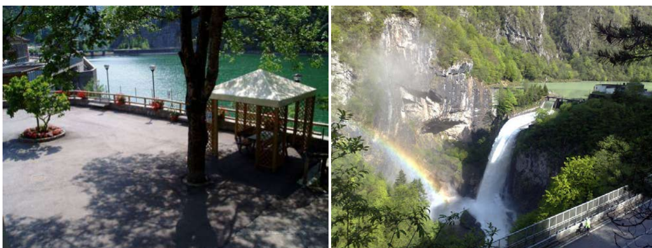
Figura 9-2: Vista della diga da monte dal piazzale dell'albergo "Al Lago" (a sinistra) e vista della diga e delle opere di scarico dalla SS n.50 (a destra).
