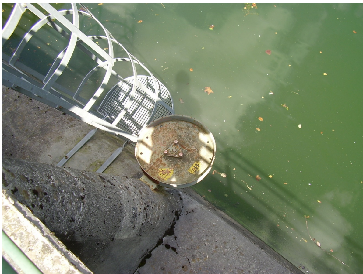
Figura 9-7: fotografia della Mira01 sulla pila che verrà demolita: una base simile sarà realizzata sulla nuova pila centrale.
