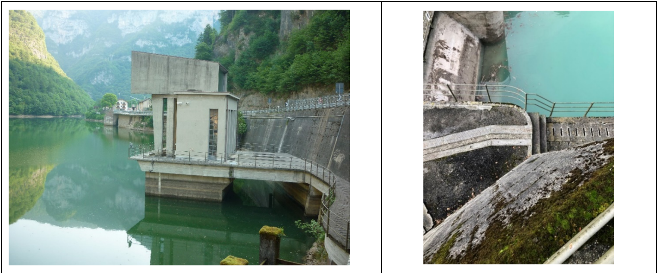
Figura 6-17: fotografia del camminamento che collega sfioratore e opera di presa passando sotto la casa di guardia.
