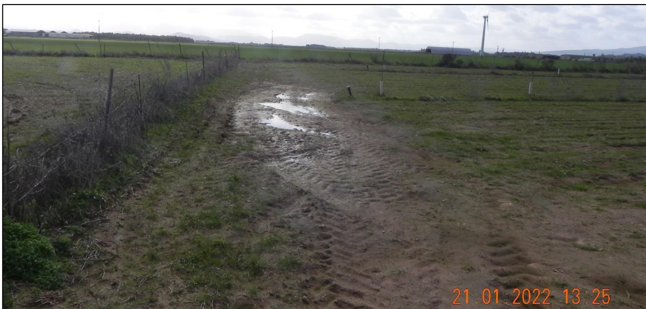
FOTO 3.1 e 3.2 – Panoramica del comparto sud con evidenza dei ristagni idrici.
