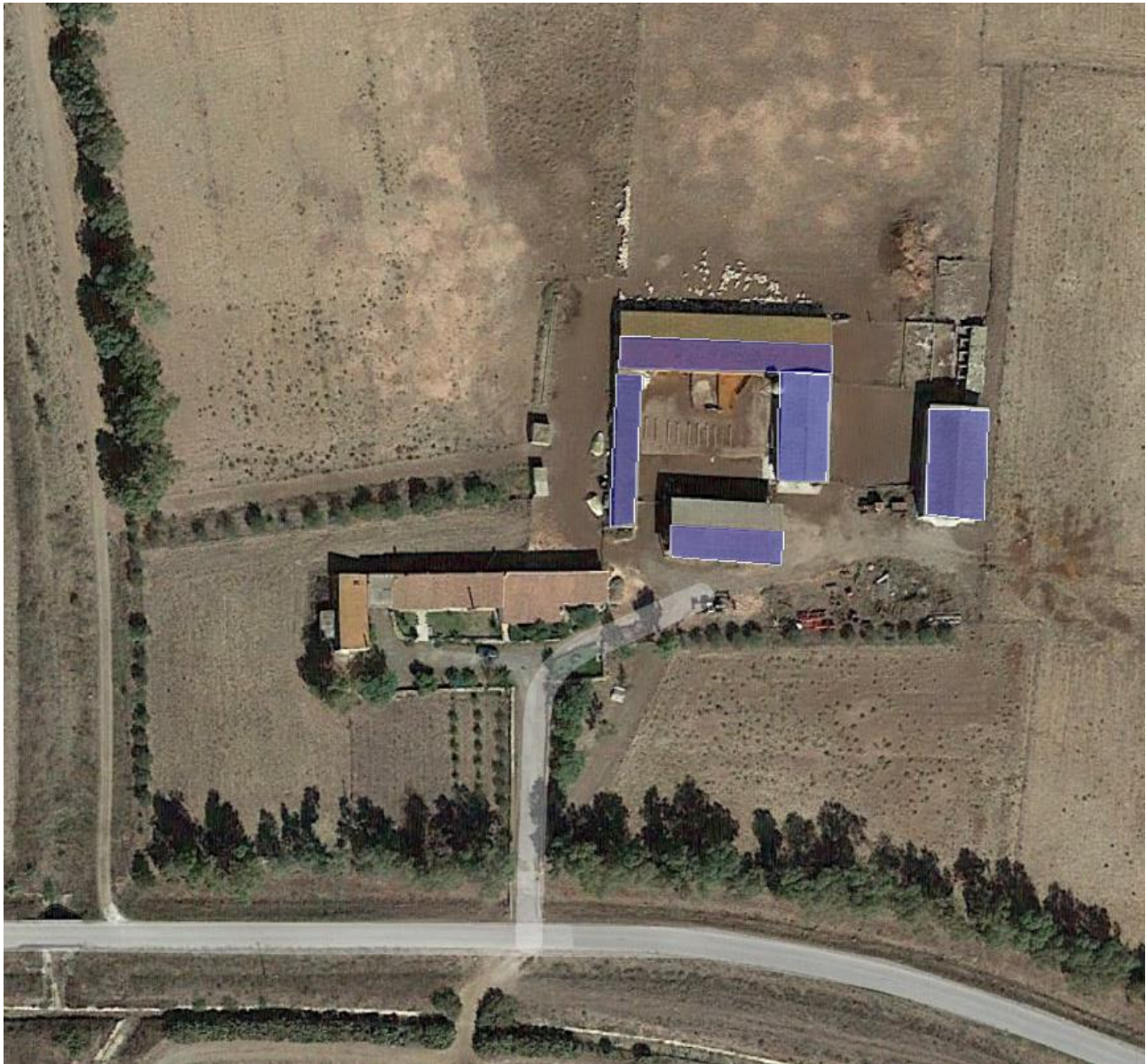
Figura 7 – Coperture esistenti sfruttabili per l'installazione di impianti fotovoltaici presso l'esistente azienda agricola con annessi sistemi di accumulo elettrochimico e ricarica per veicoli elettrici
