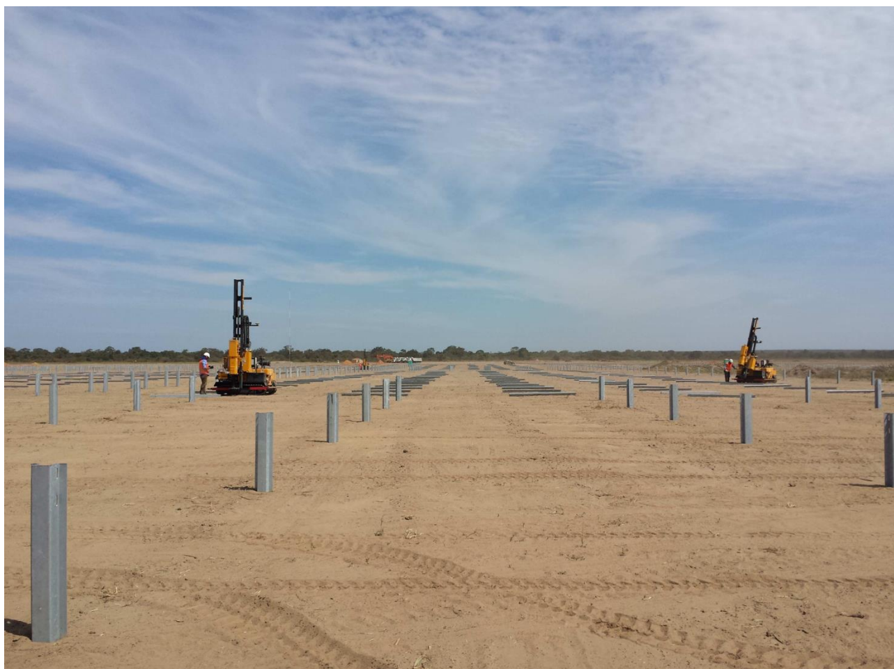
Figura 7.3 – Fase di infissione dei pali con profilo omega (fonte Convert)
