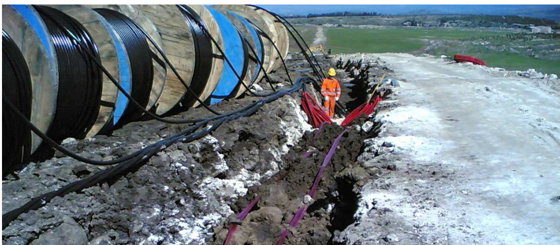
Posa in opera dei cavidotti interrati
