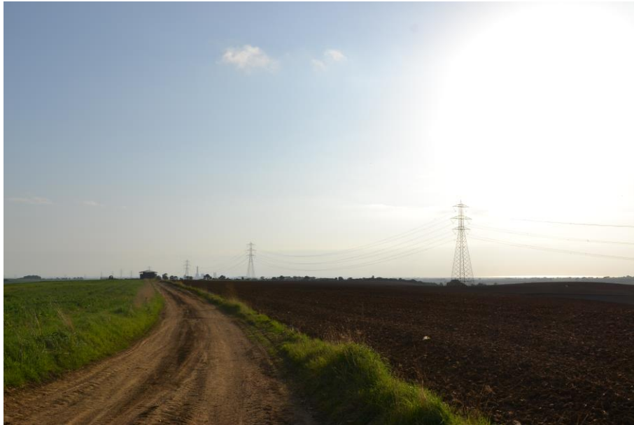
Figura 37. Linea AT 'Montalto-Suvereto' e viabilità campestre nell'area SE Terna
