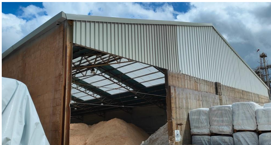
Foto 12 – tamponatura dell'attuale capannone di stoccaggio idrato di alluminio – lato ovest
