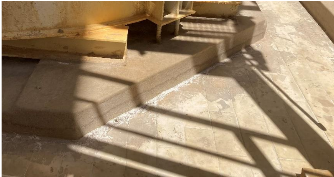
Foto 3 – Particolare dell'appoggio e del bacino di contenimento del serbatoio oleum (D803)
