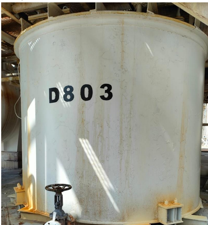
Foto 2 – Verniciatura e ripristino del mantello del serbatoio oleum (D803)
