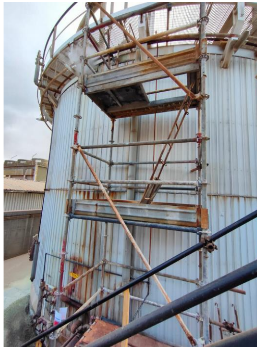
Figura 10 – Intervento su tubazioni vapore serbatoio D801-2
