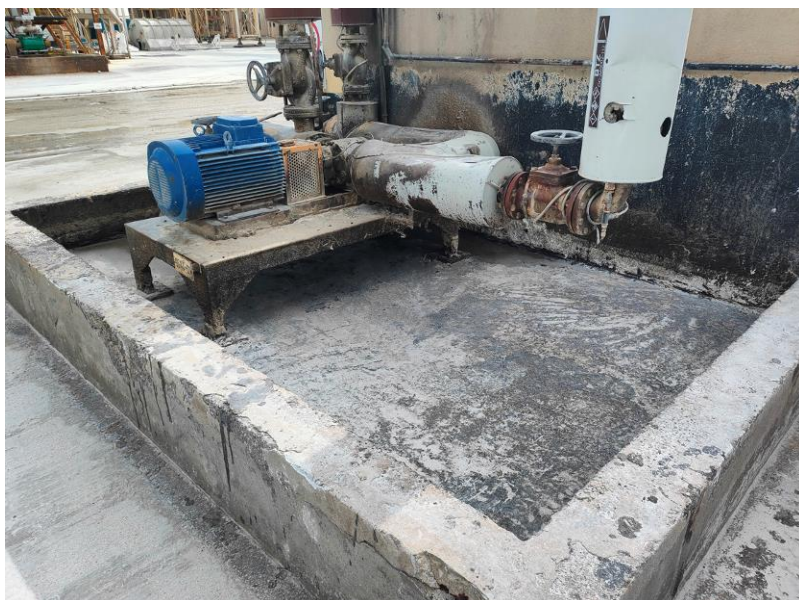
Figura 21 – Baia ospitante la pompa GSA4-01 - post-intervento di pulizia
