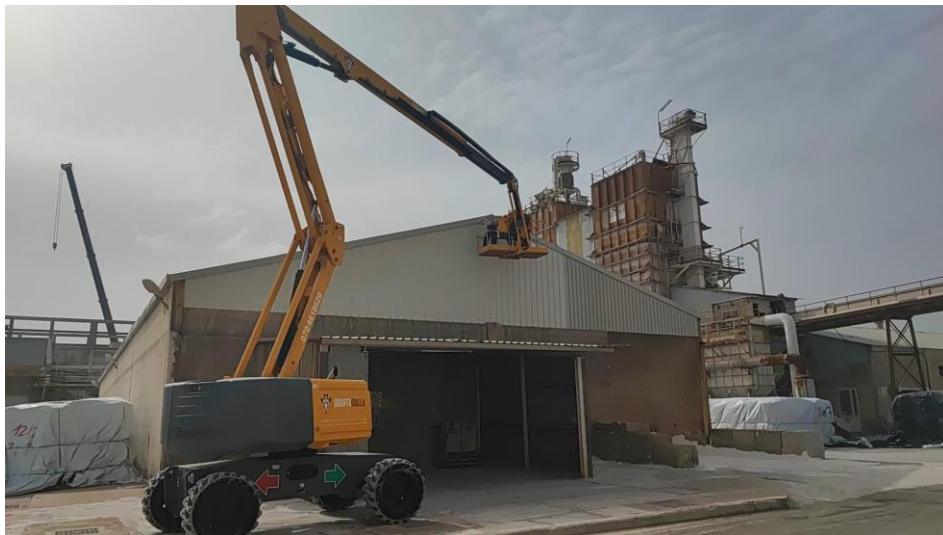
Foto 10 – Tamponatura dell'attuale capannone di stoccaggio idrato di alluminio – lato est
