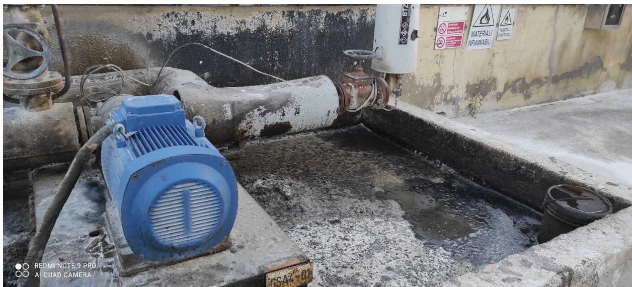
Figura 20 – Baia ospitante la pompa GSA4-01 di scarico dell’olio combustibile BTZ dall’autocisterna al serbatoio DSA4-002 (cfr. ISPRA - RAPPORTO CONCLUSIVO - ALLEGATO 01 Relazione Fotografica Visita in loco Fluorsid del 06-07 ottobre 2021 – Figura 89)
