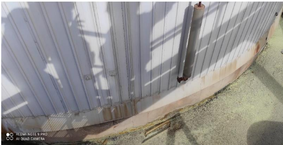
Figura 7 – Serbatoi zolfo – particolari tubazioni vapore e scarichi condense (cfr. ISPRA - RAPPORTO CONCLUSIVO - ALLEGATO 01 Relazione Fotografica Visita in loco Fluorsid del 06-07 ottobre 2021 – Figura 31 – Figura 33)
