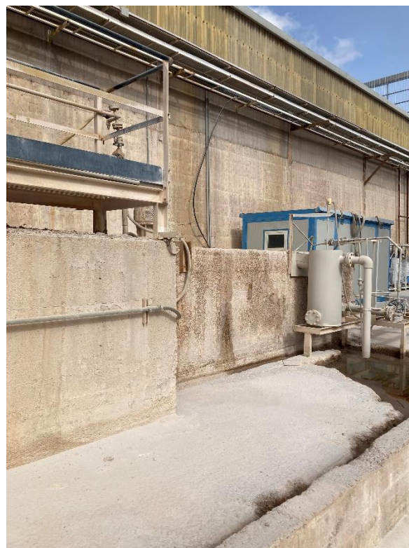
Foto 6 –Bacino di contenimento della vasca dei fanghi dello scrubber presso impianto FL1 – post intervento di pulizia
