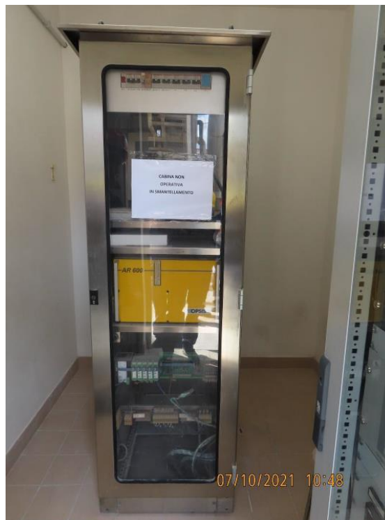
Figura 2 – Quadro SME da dismettere (cfr. ISPRA - RAPPORTO CONCLUSIVO - ALLEGATO 01 Relazione Fotografica Visita in loco Fluorsid del 06-07 ottobre 2021 –Figura 57)
