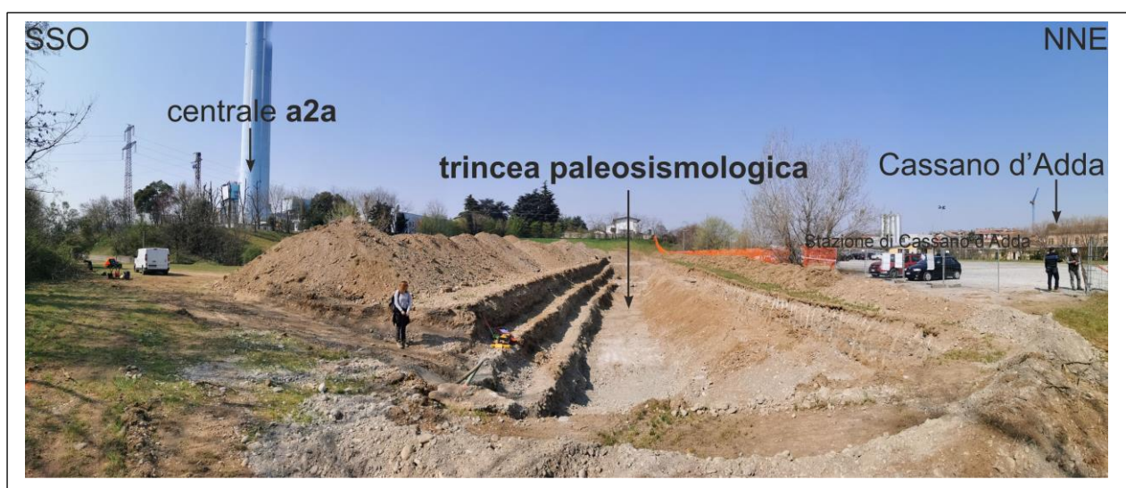
Fig. 16. Fotografia della trincea paleosismologica (vista verso ONO) realizzata a ridosso della centrale a2a.
