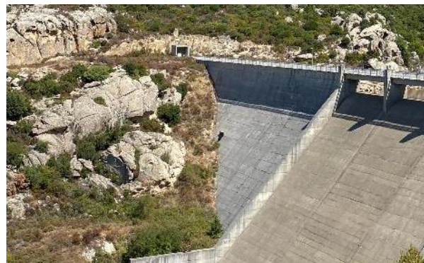
Figura 17 - Vista ingresso cunicolo sponda Nord
