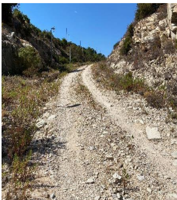
Figura 12 - Pista di accesso al coronamento
