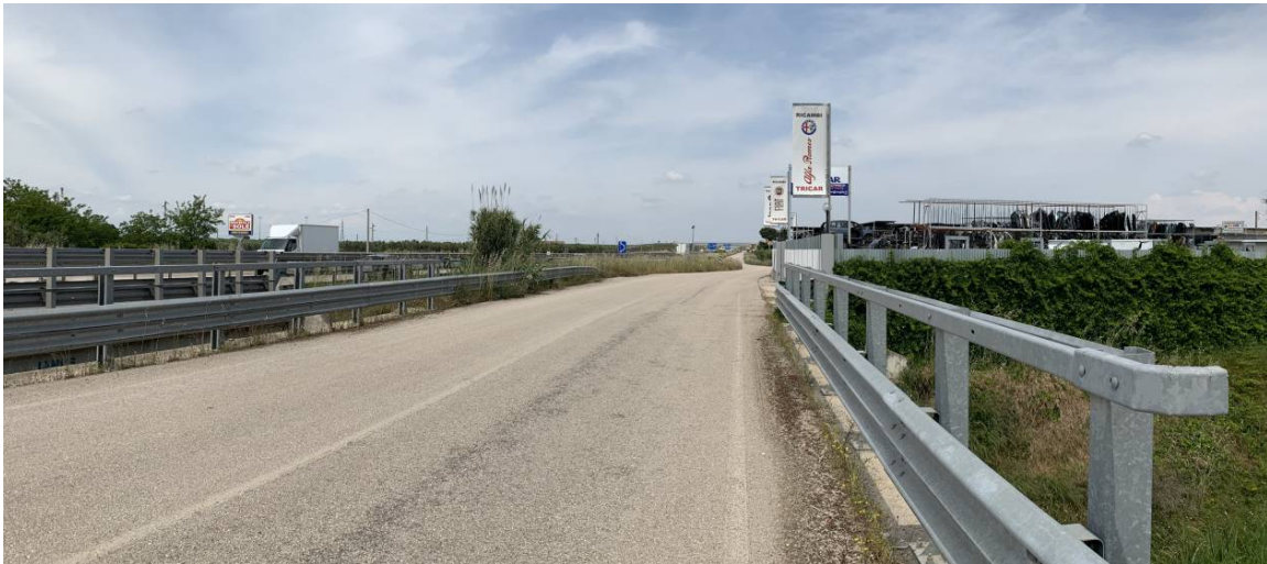
Foto S7.2: Vista della complanare della SS16, in direzione di Foggia
