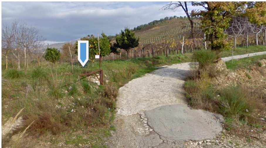
Figura 77 Vista innesto pista di cantiere dalla viabilità esistente
