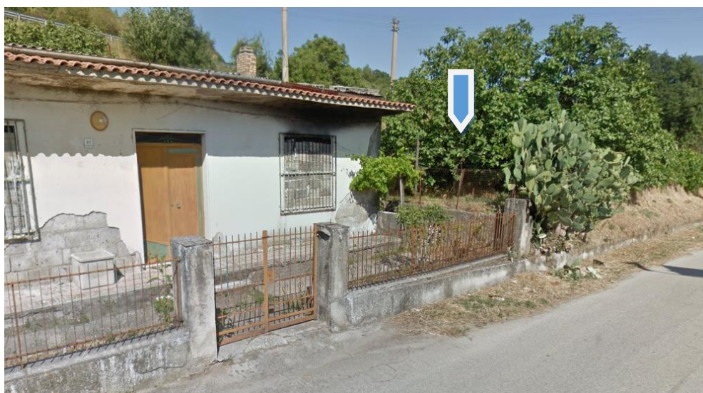
Figura 28 Vista dell'area di lavoro e dell'edificio da demolire
