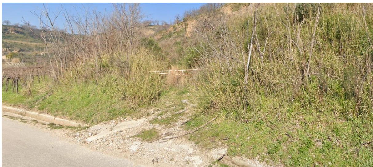
Figura 61 Vista zona di uscita pista di cantiere sulla SP106
