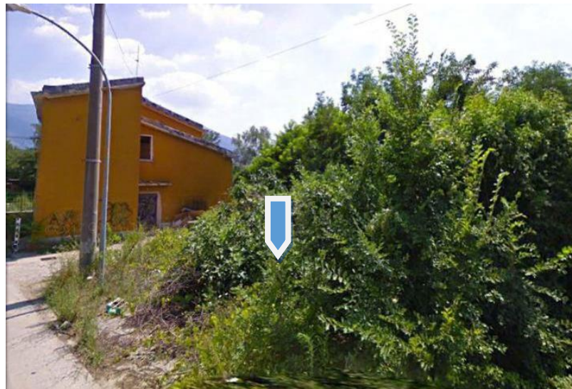
Figura 124 Vista da nord area di cantiere
