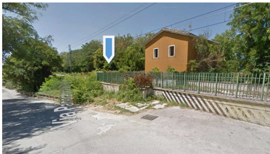
Figura 125 Vista da sud area di cantiere
