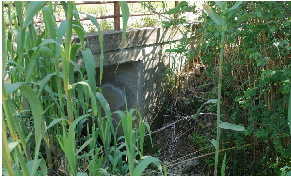
Figura 43 Vista del attraversamento esistente
