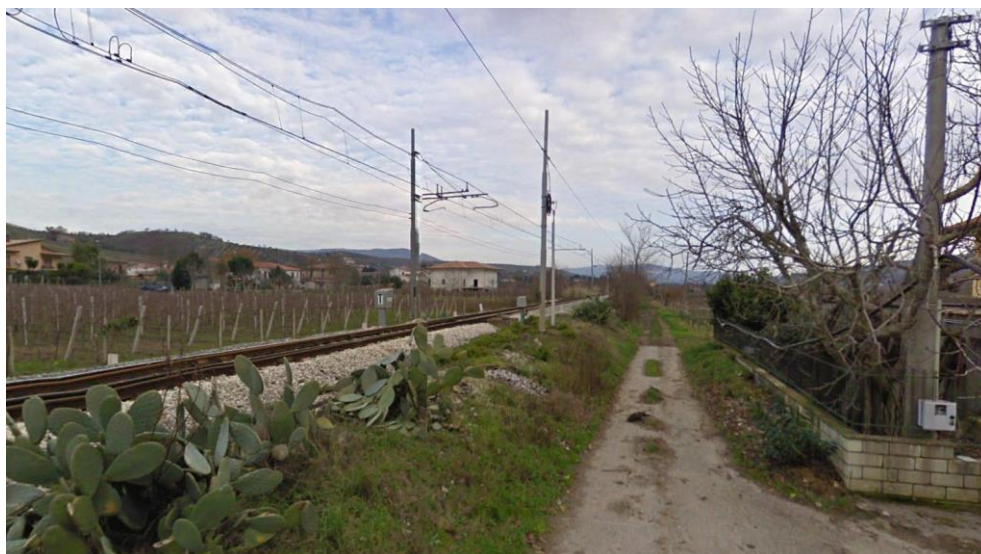
Figura 9: sede stradale attuale - carenza di protezioni marginali, assenza della sovrastruttura stradale, assenza di segnaletica orizzontale e verticale
