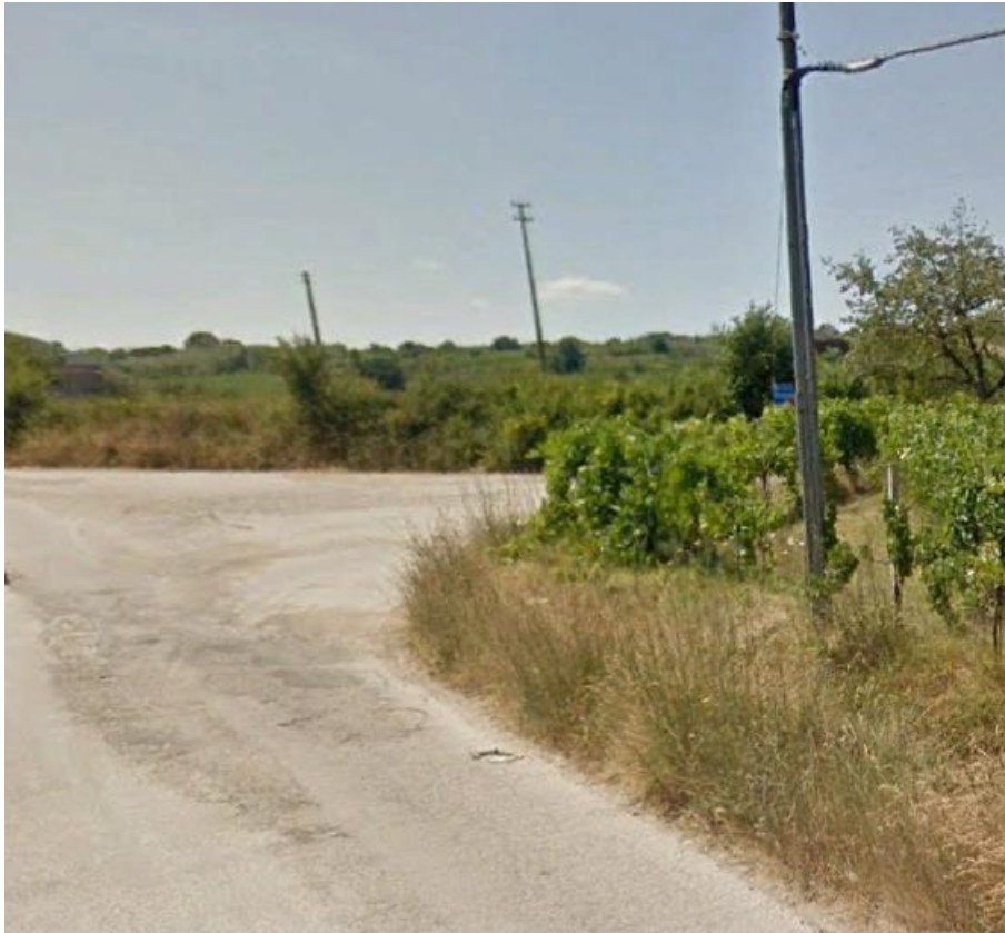
Figura 10: sede stradale attuale - ammaloramento avanzato della sovrastruttura stradale
