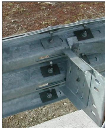
Particolare attenzione dovrà essere posta al posizionamento delle piastre di ancoraggio tra la barriera ed il cordolo che non devono essere mai posizionati a cavallo del giunto perché ne ostacolerebbero il libero movimento.
