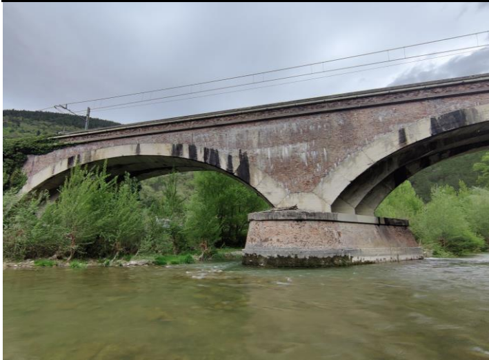
Ponte FS esistente sul F. Esino (Palombare)
