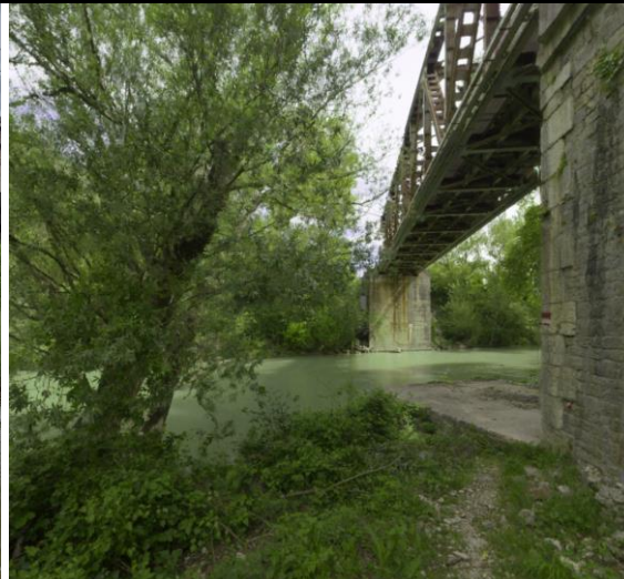
Ponte FS esistente sul F. Esino (Gola Rossa)
