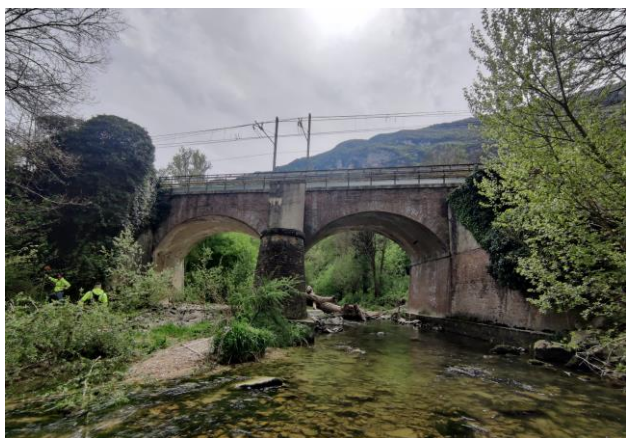
Ponte FS esistente sul F. Esino
