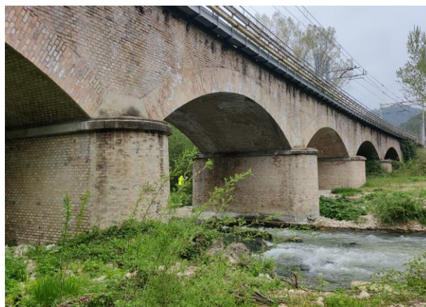
Ponte FS esistente sul T. Sentino
