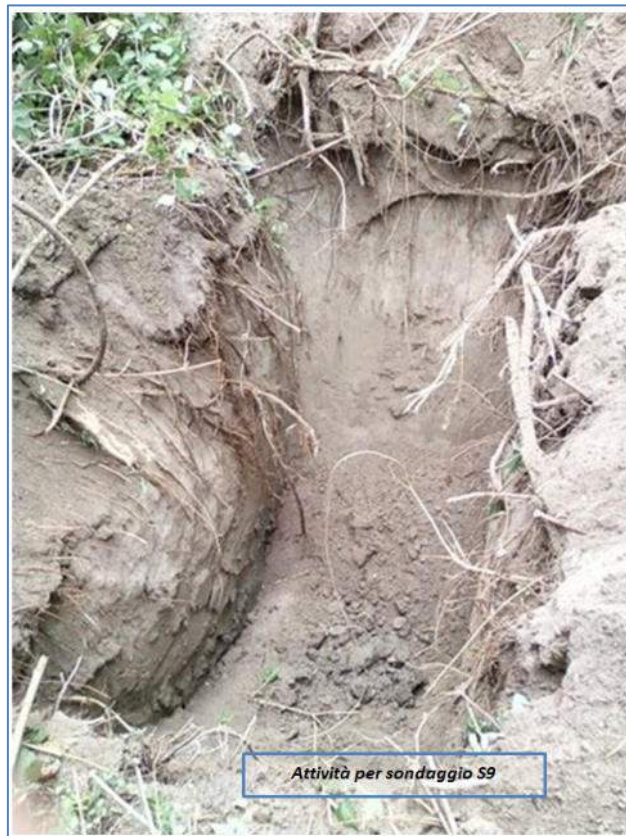
Figura 7-14: Documentazione fotografica per sondaggio S9
