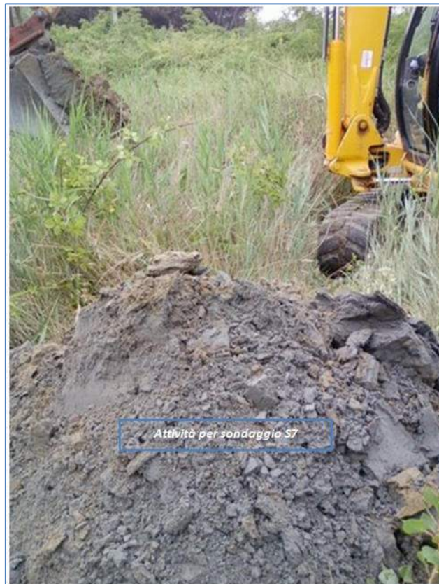
Figura 7-12: Documentazione fotografica per sondaggio S7
