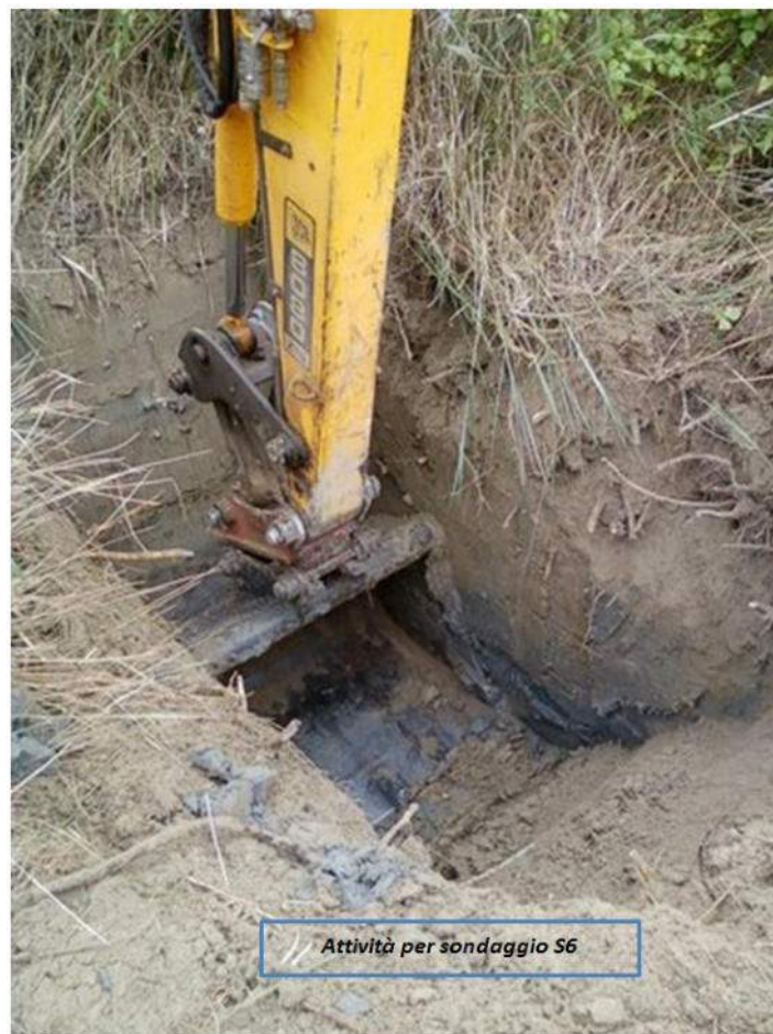
Figura 7-11: Documentazione fotografica per sondaggio S6
