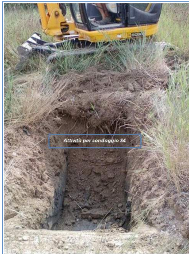
Figura 7-8: Documentazione fotografica per sondaggio S4
