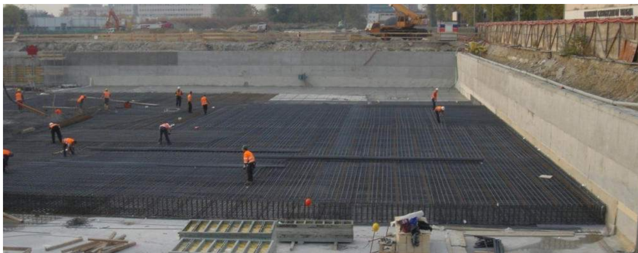
Figura 6-2: esempio di costruzione platea
