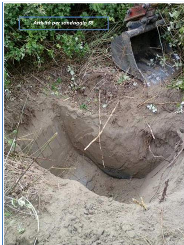
Figura 7-13: Documentazione fotografica per sondaggio S8
