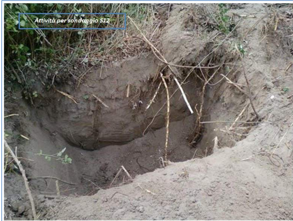
Figura 7-17: Documentazione fotografica per sondaggio S12
