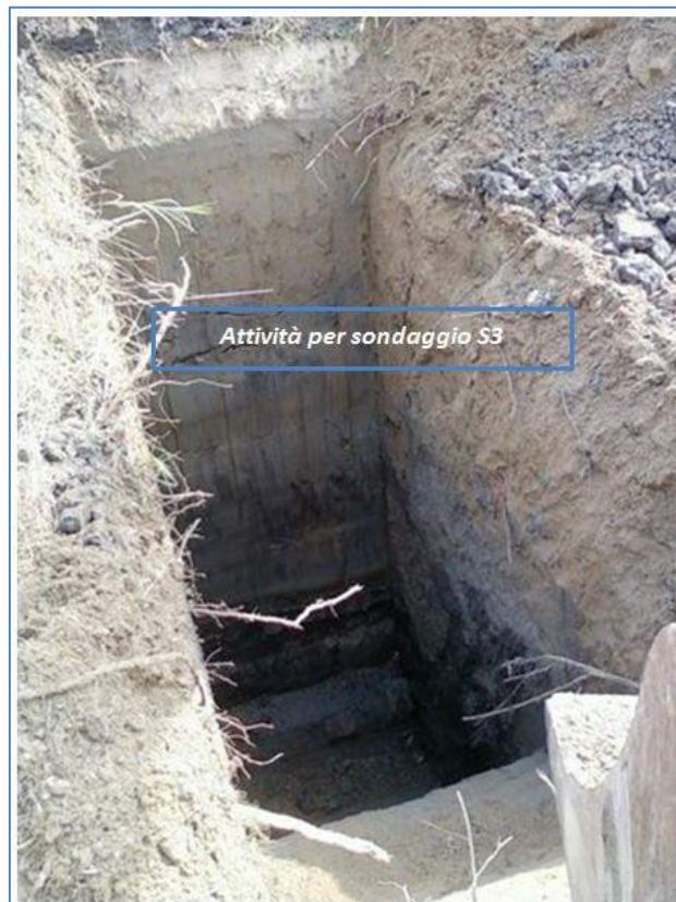
Figura 7-7: Documentazione fotografica per sondaggio S3
