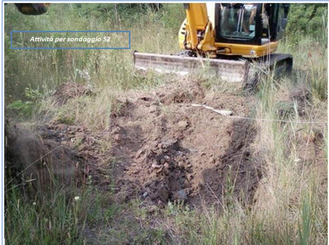
Figura 7-5: Documentazione fotografica per sondaggio S2
