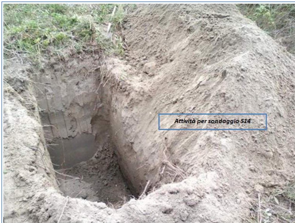
Figura 7-19: Documentazione fotografica per sondaggio S14
