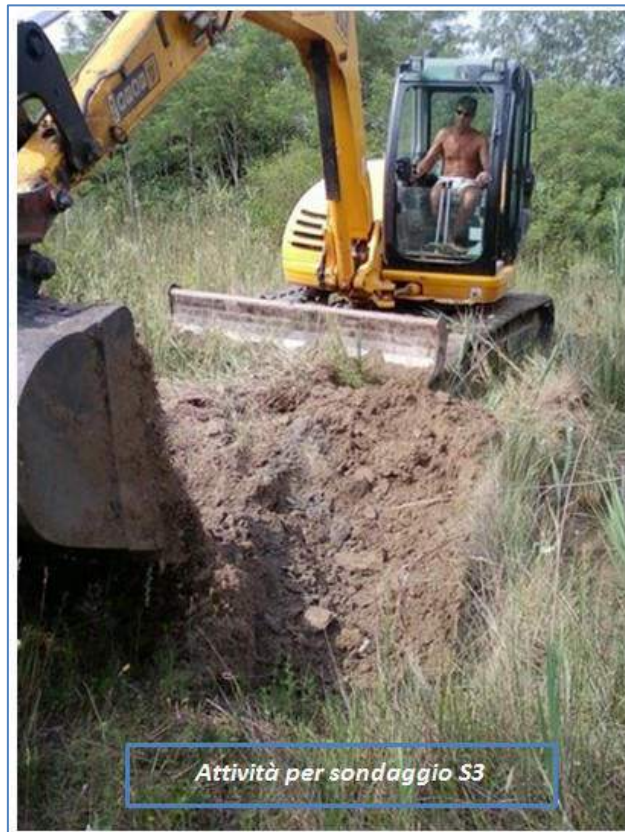
Figura 7-6: Documentazione fotografica per sondaggio S3
