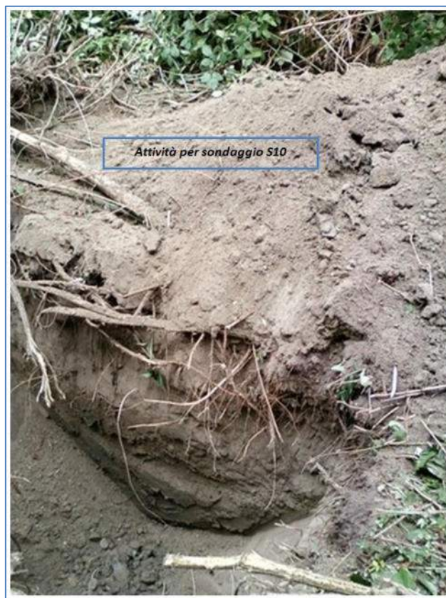
Figura 7-15: Documentazione fotografica per sondaggio S10
