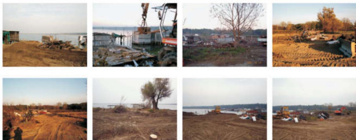
Figura 3-36: rimozione delle cavane e spianamento dell'area
