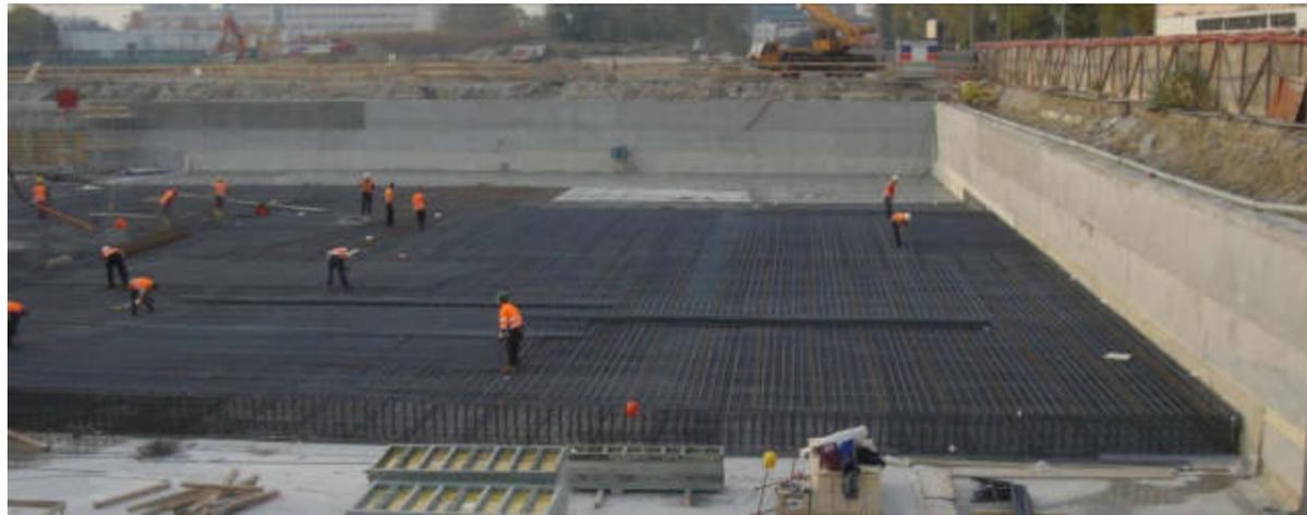
Figura 3-31: esempio di costruzione platea
