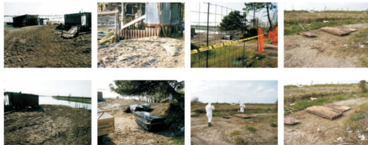
Figura 3-38: bonifica delle coperture in eternit delle cavane
