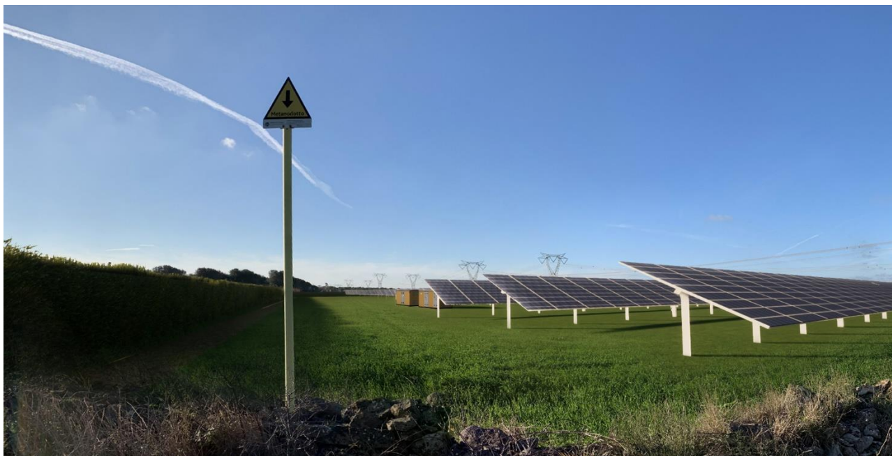
Area centrale di impianto – post operam con mitigazione perimetrale
