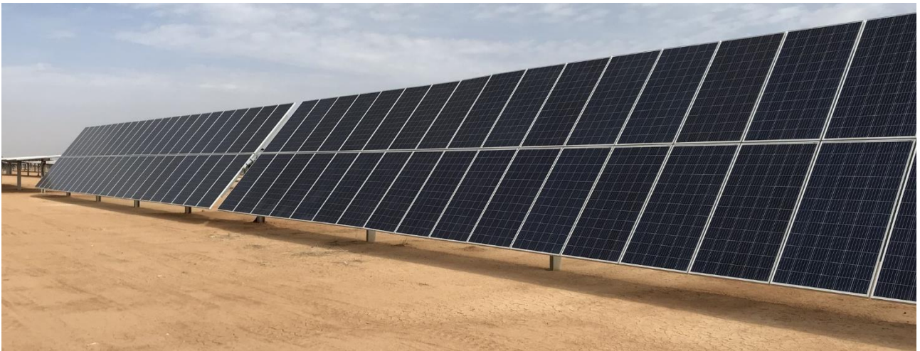
Figura 20 - Inseguitore monoassiale vista frontale
