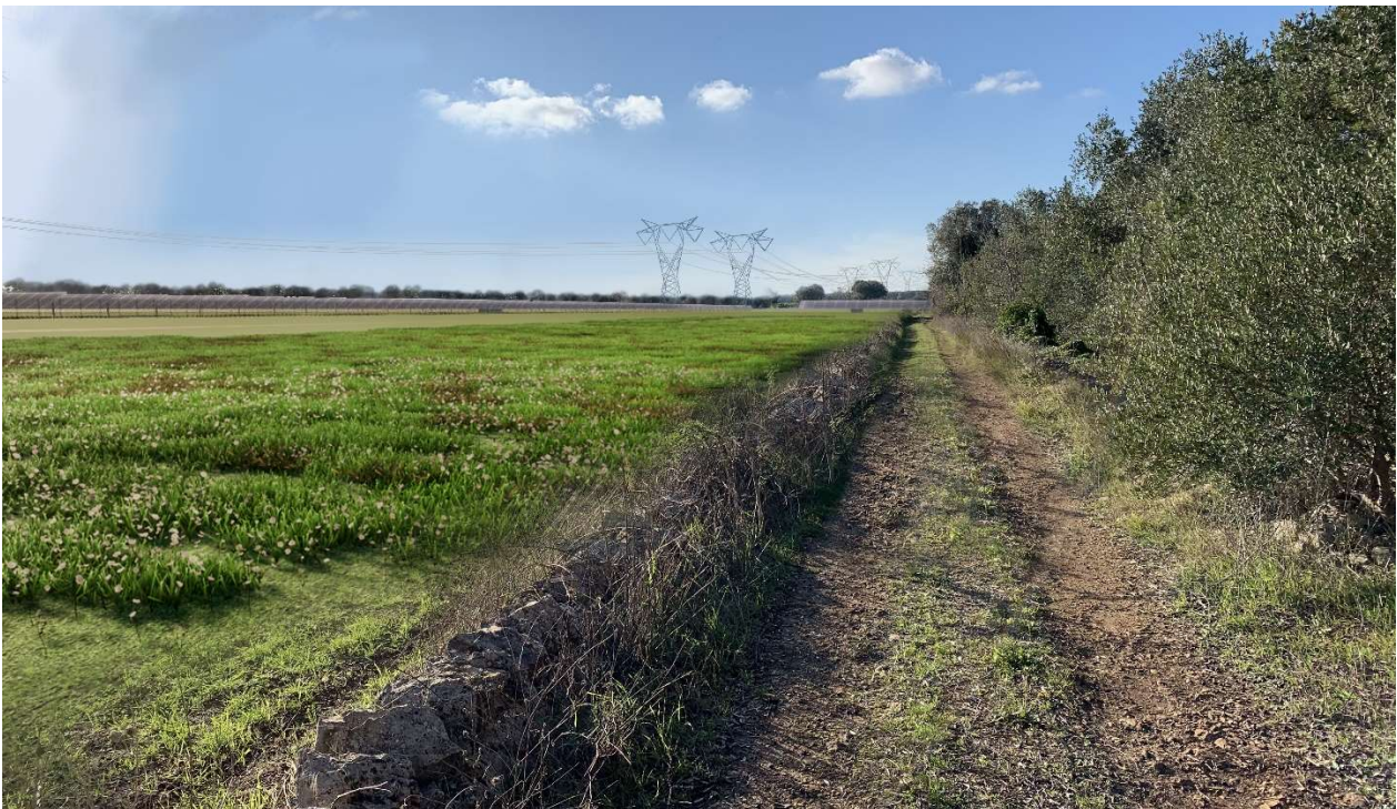
Area Nord-Est di impianto – post operam
