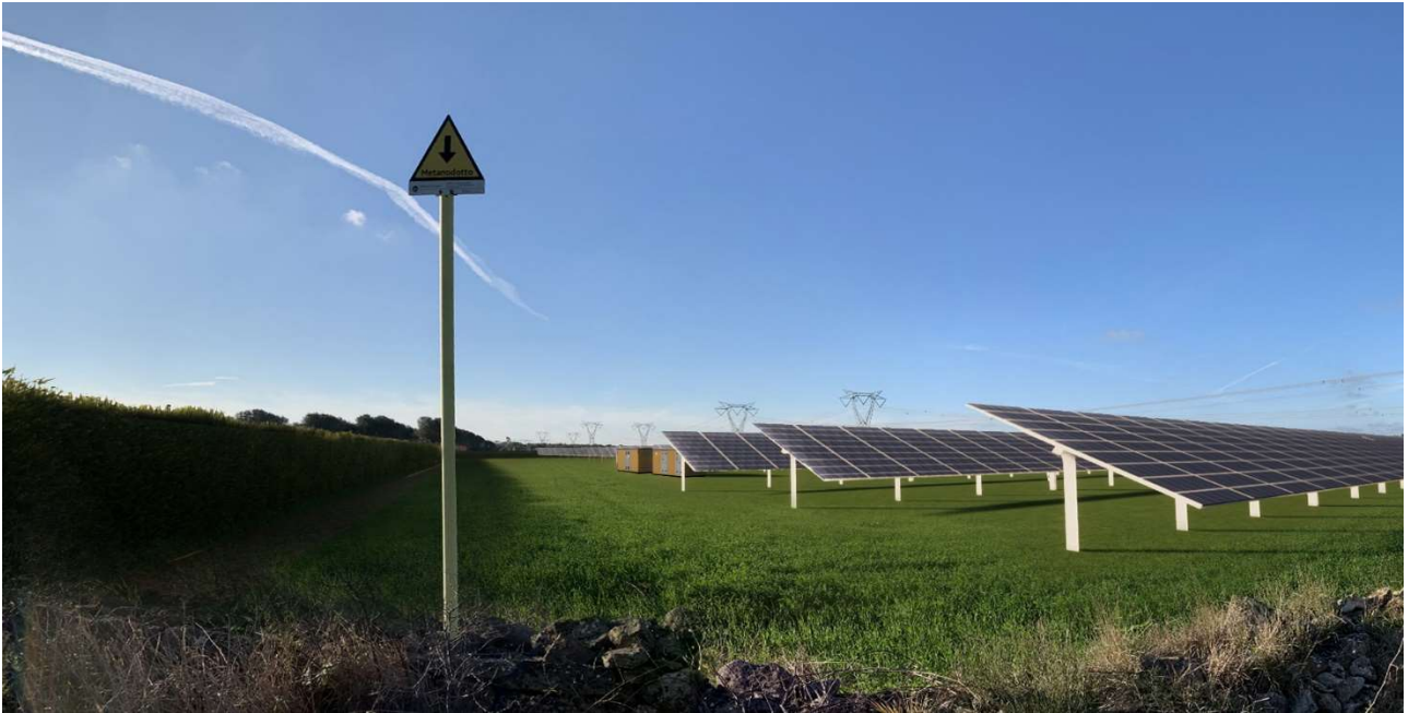
Area centrale di impianto – post operam con mitigazione perimetrale
