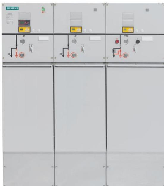
Figura 12 – Vista frontale quadro di protezione in media tensione della cabina di trasformazione
