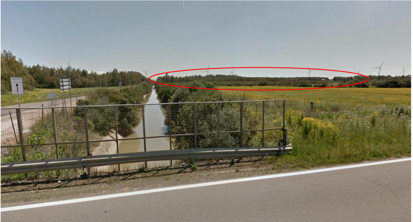
Figura 50: Vista situazione attuale da PB B sul ponte della SP 61.
