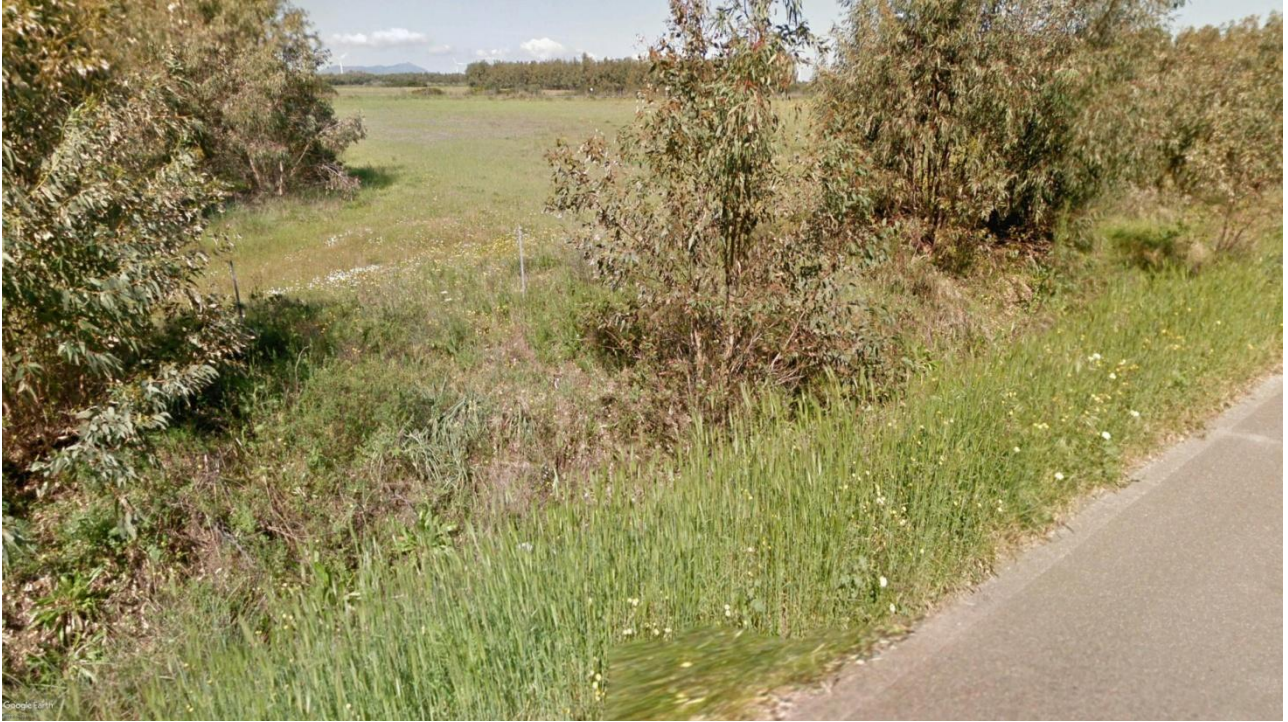
Figura 33: Vista sulla SP 4.
