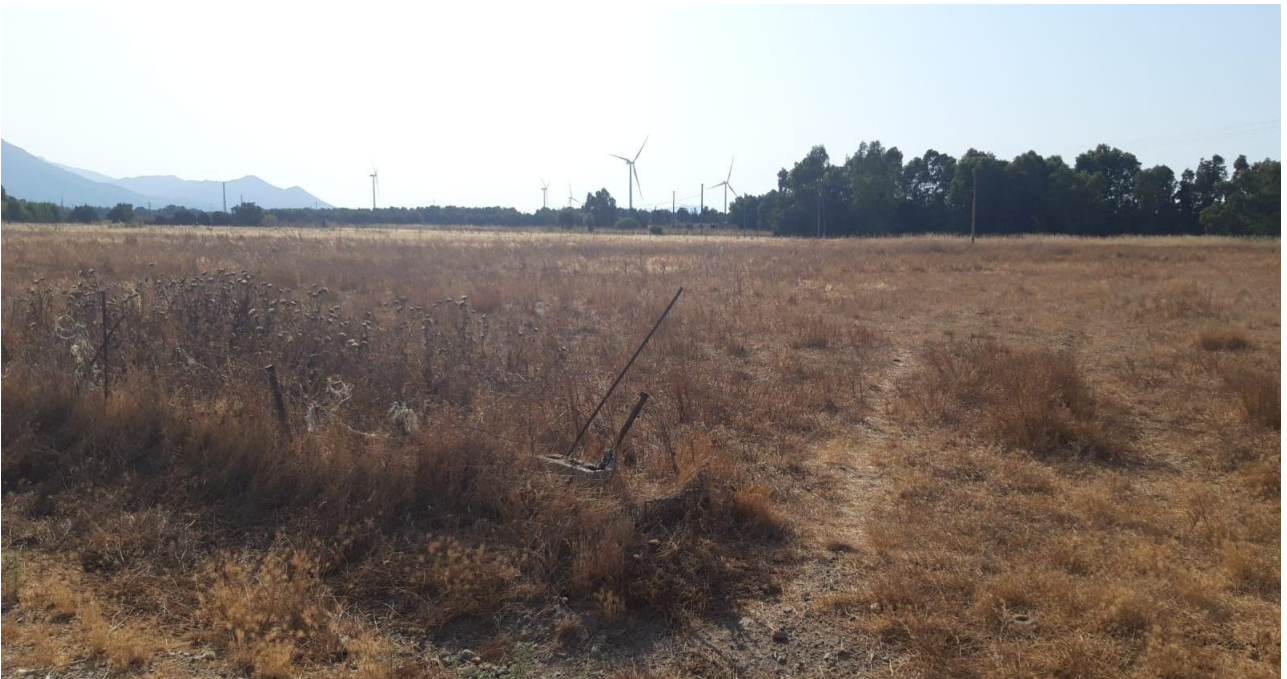
Figura 33: Vista su impianto a Eolico.
