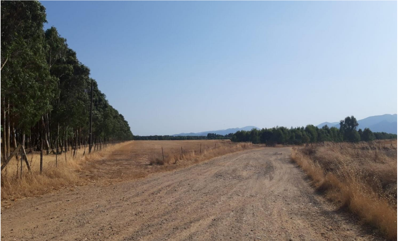
Figura 51: Vista da PB 03 Ante operam.
