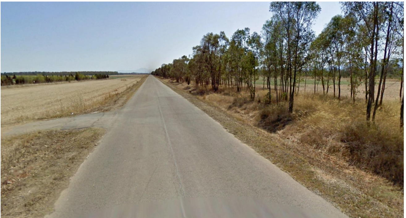
Foto 12: sopralluogo UR 12 - giugno 2021.
