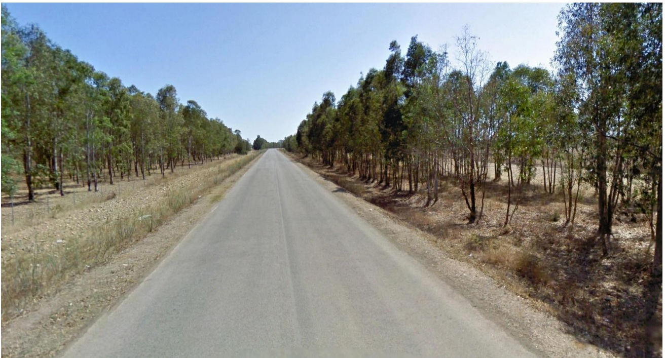
Foto 10: sopralluogo UR 10 - giugno 2021.
