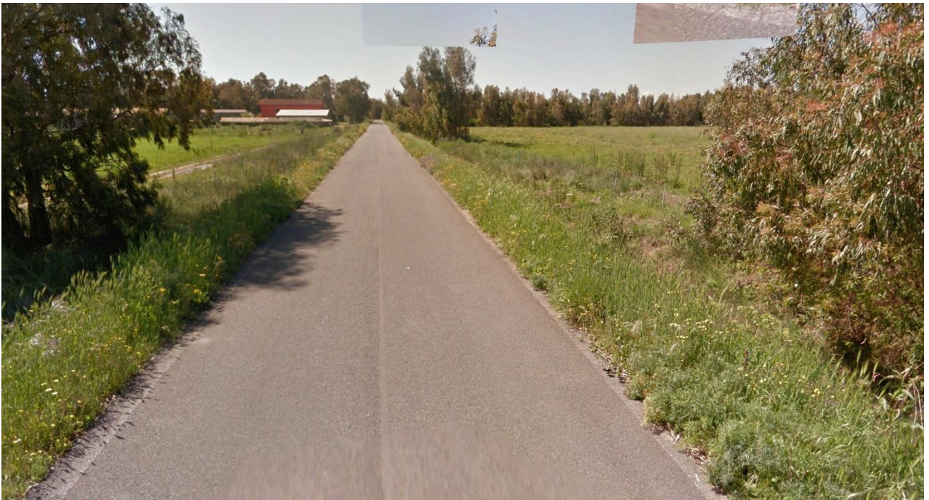
Foto 4: sopralluogo UR 4 - giugno 2021.
