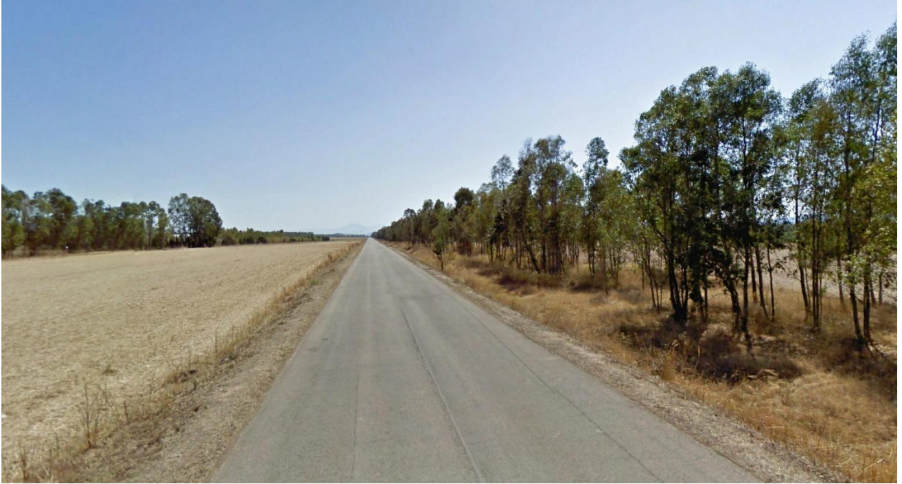
Foto 11: sopralluogo UR 11 - giugno 2021.
