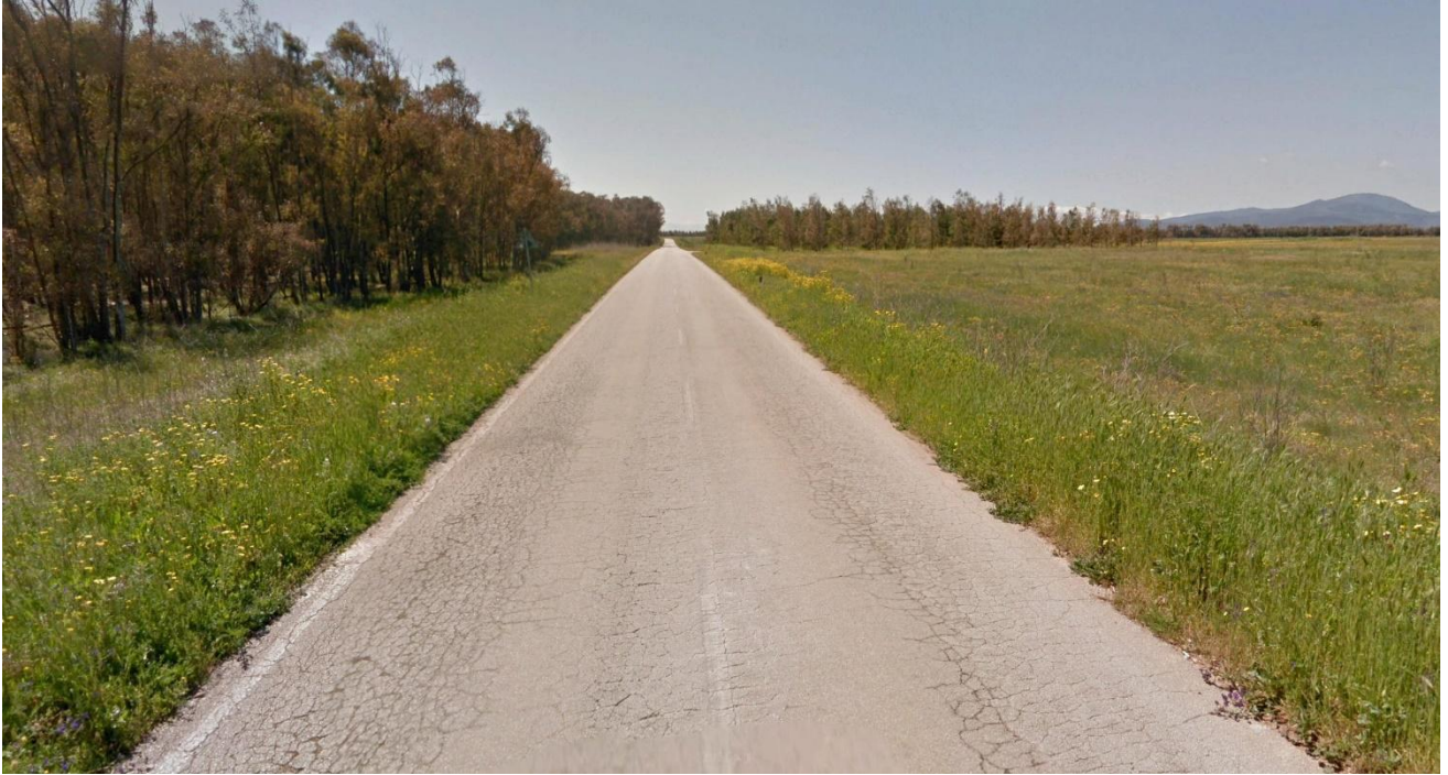
Foto 7: sopralluogo UR 7 - giugno 2021.
