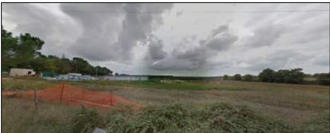
Figura 2.4.2e Impianto fotovoltaico esistente in prossimità dell’area FV3
