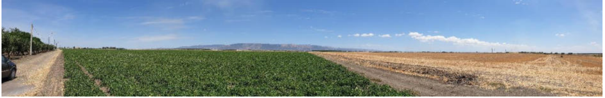
Figura 2.3: Linee Elettriche di Bassa Tensione del Sottocampo B
