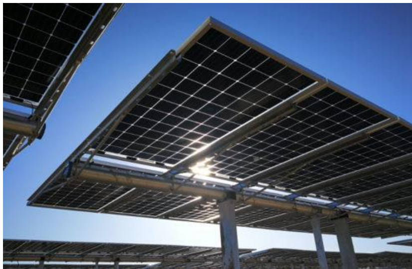
Figura 2.8 Esempio di struttura a tracker monoassiale.
