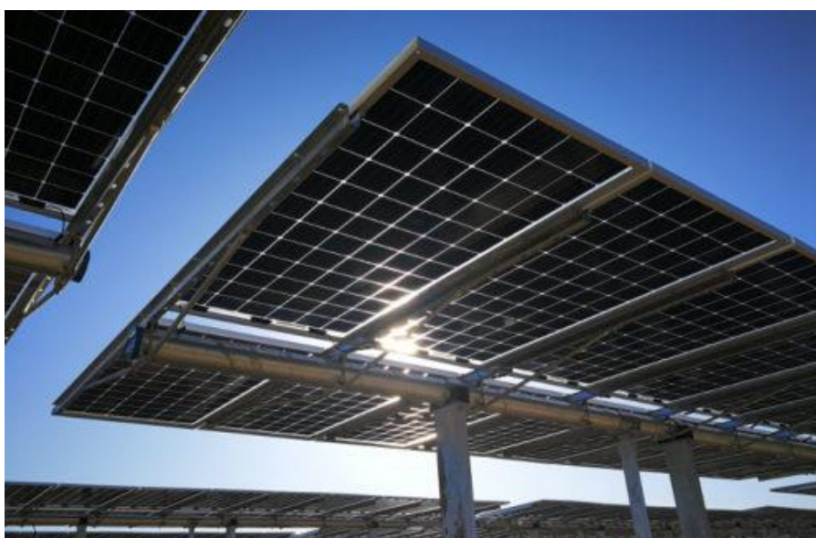
Figura 2.8 Esempio di struttura a tracker monoassiale
