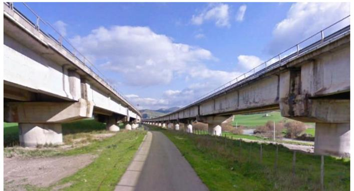
Lavori di ripristino strutturale mediante interventi sulle travi, solette, sostituzione degli appoggi e ripristino corticale dei pulvini e trasversi del viadotto Morello lungo la A19 "Palermo - Catania"
