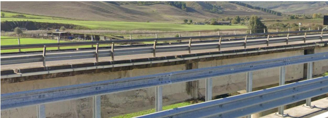
Figura 3.1. Canaletta in VTR ancorata al cordolo lato interno per l'intero sviluppo del viadotto (vista dalla carreggiata CT-PA)
