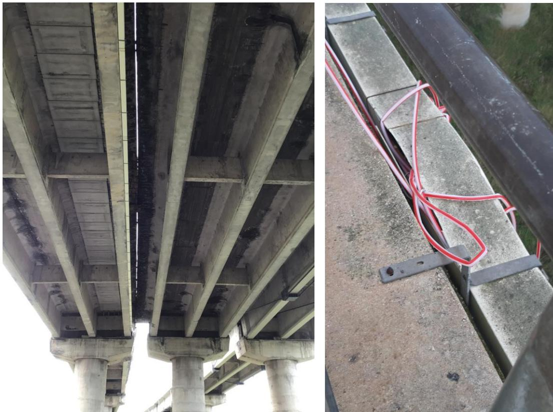
Figura 3.2. Canaletta in VTR ancorata alla trave di bordo in corrispondenza del by-pass e dettaglio della canaletta e delle staffe di ancoraggio al cordolo
